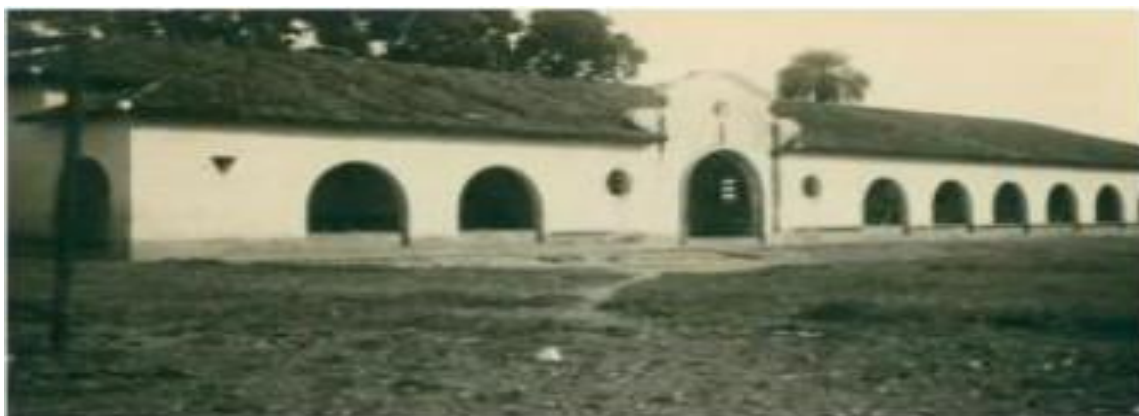
Figura 91 – Fotografia da fachada do Abrigo Bom Jesus
