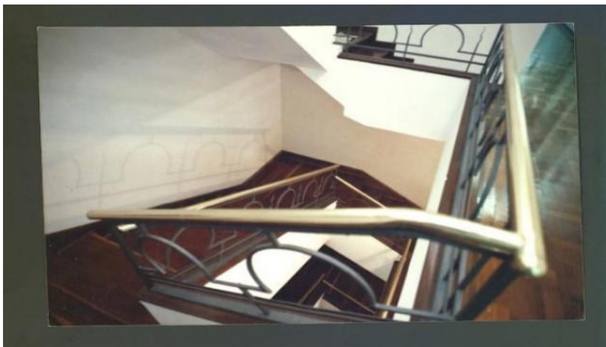
Figura 111 – Fotografia da escada de acesso às unidades habitacionais
