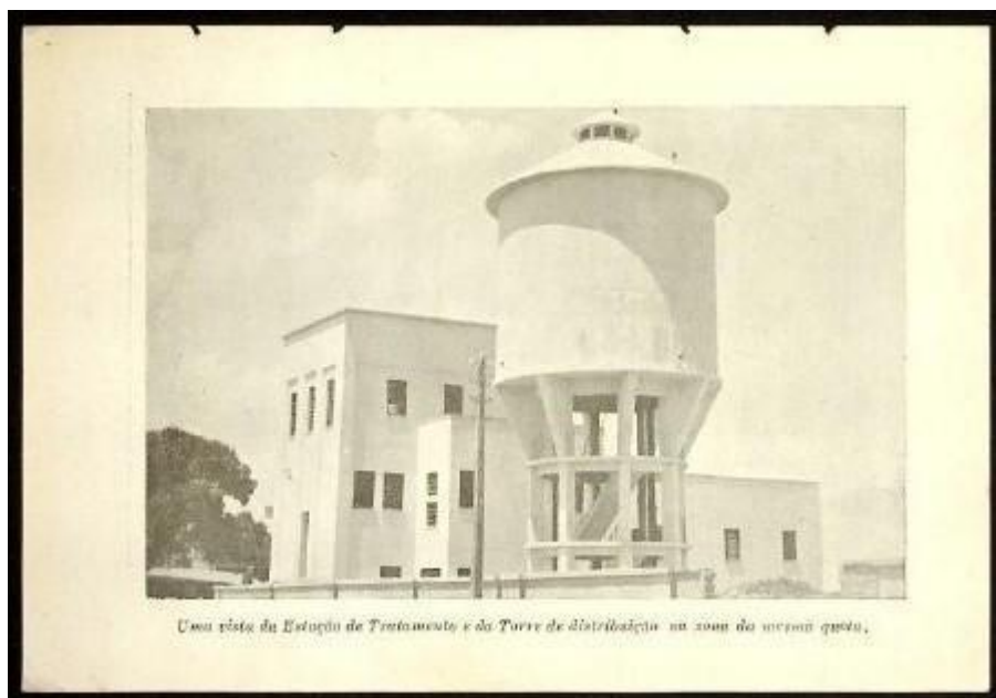
Figura 76 – Fotografia da Estação de Tratamento de Água
