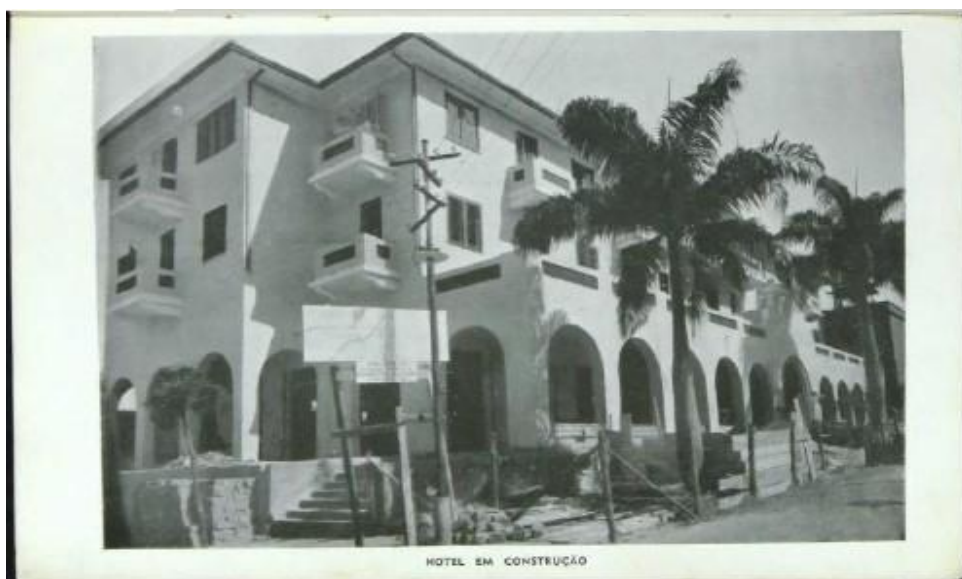
Figura 44 – Fotografia do Grande Hotel em fase de construção
