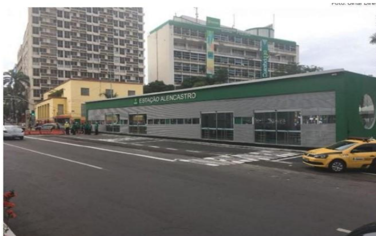
Figura 69 – Fotografia da Estação Alencastro
