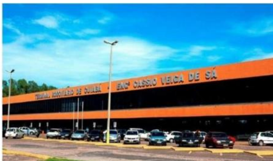
Figura 127 - Fotografia do Terminal Rodoviário de Cuiabá Engenheiro Cássio Veiga De Sá
