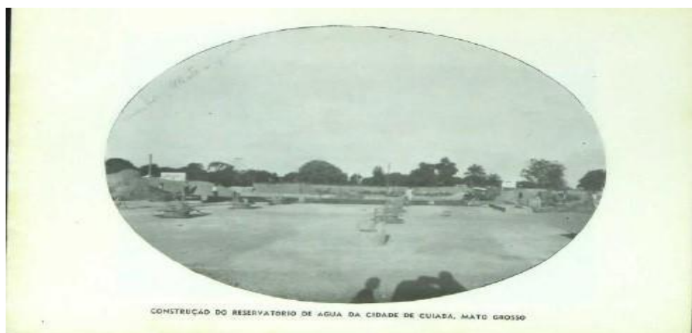
Figura 77 – Fotografia da construção do reservatório de água de Cuiabá
