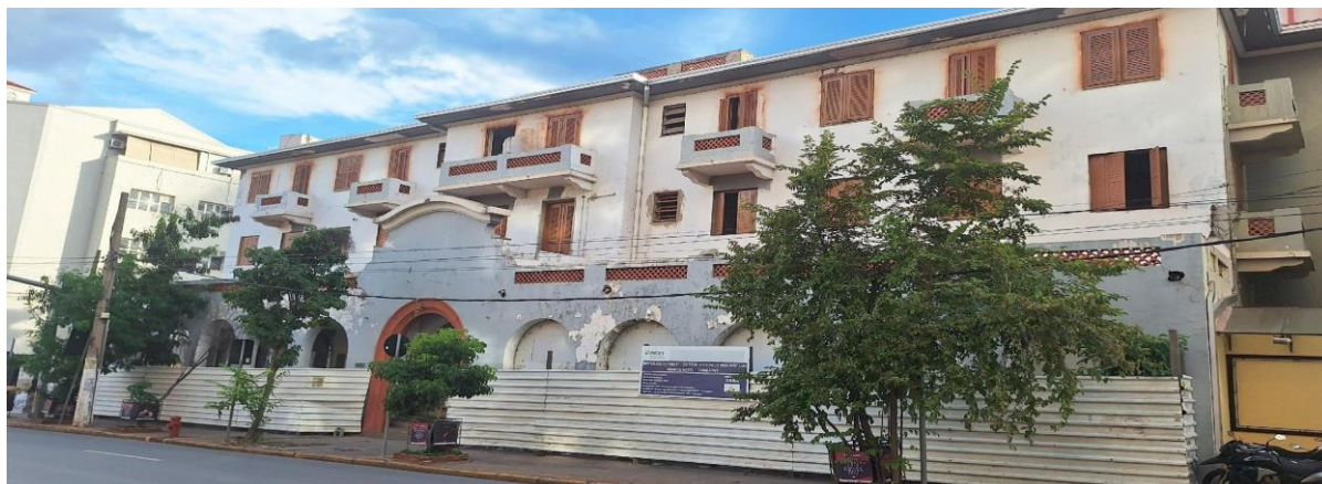
Figura 105 – Fotografia da fachada do Grande Hotel em restauro/retrofit
