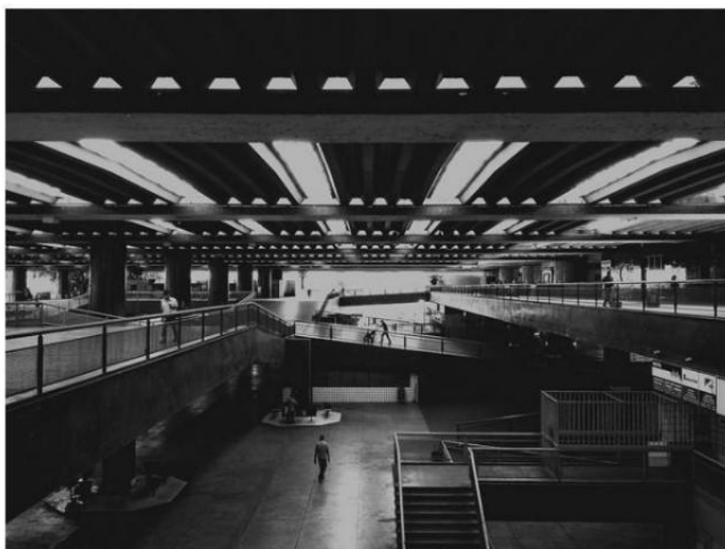
Figura 128 – Fotografia da parte interna do Terminal Rodoviário de Cuiabá
