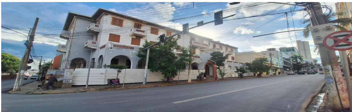
Figura 104 – Fotografia do Grande Hotel à Avenida Getúlio Vargas esquina com a Rua Joaquim Murtinho
