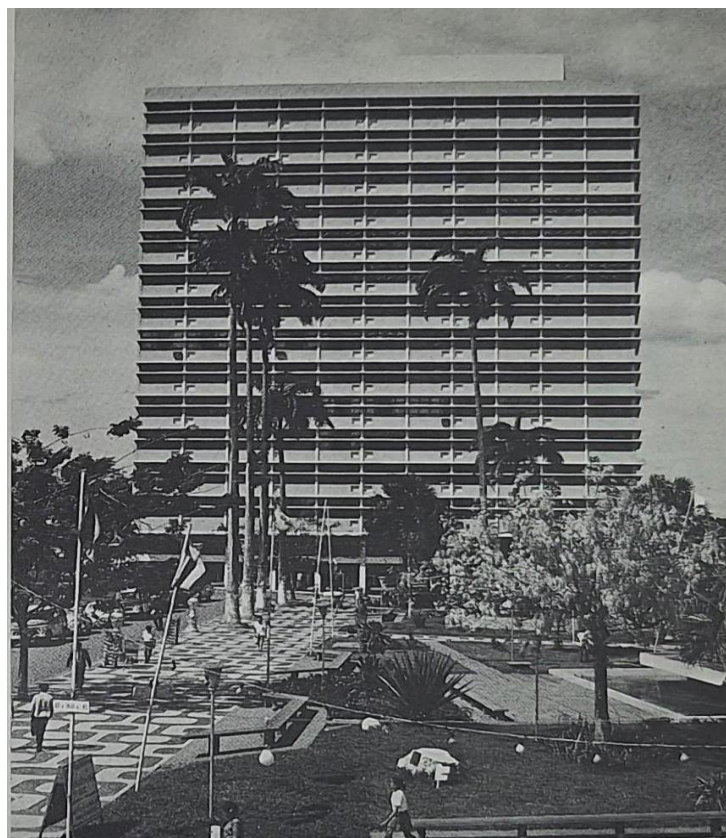
Figura 123 – Fotografia do edifício Maria Joaquina
