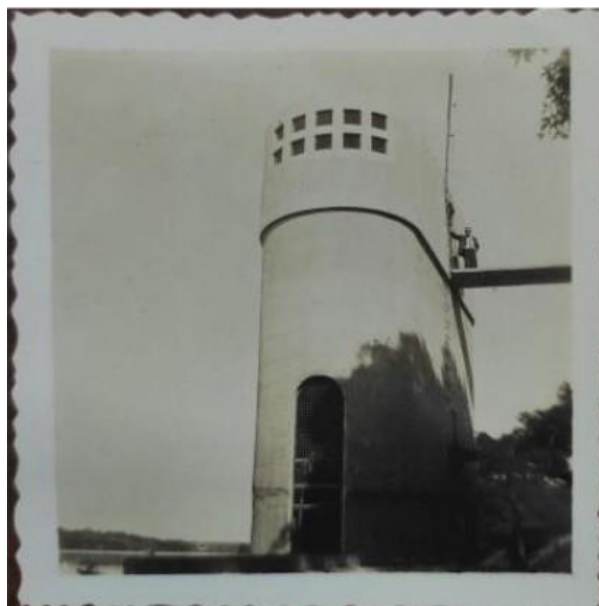
Figura 82 – Fotografia da Estação Elevatória de Água
