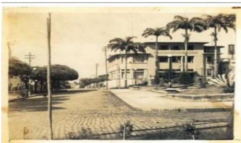
Figura 18 – Fotografia da sede da agência dos Correios e Telégrafos
