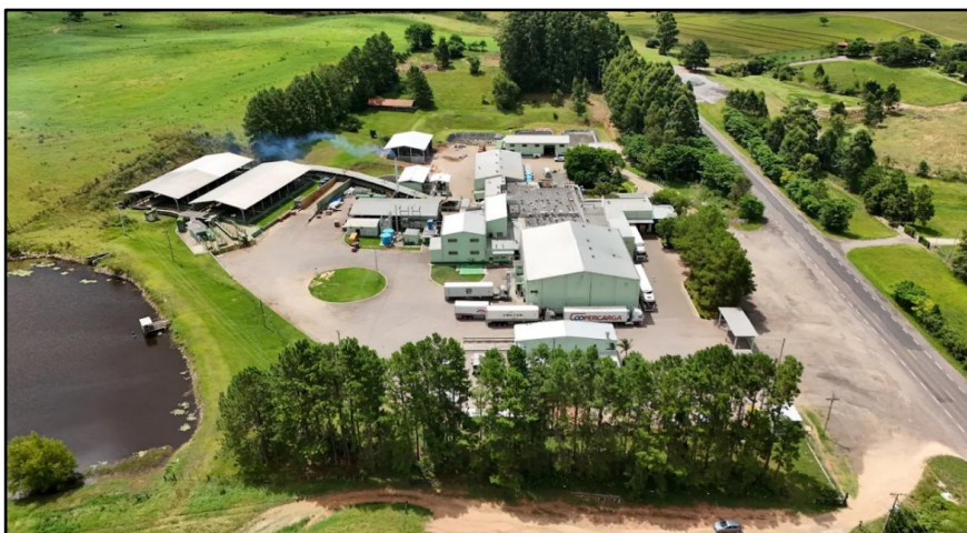
Figura 1 - Imagem aérea do frigorífico Comesul.
