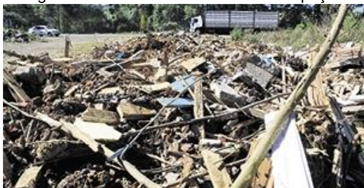
Figura 32: Entulhos no local da desocupação.
