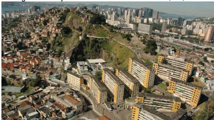
Figura 4: Conjunto Residencial dos Marítimos, RJ, 1955
