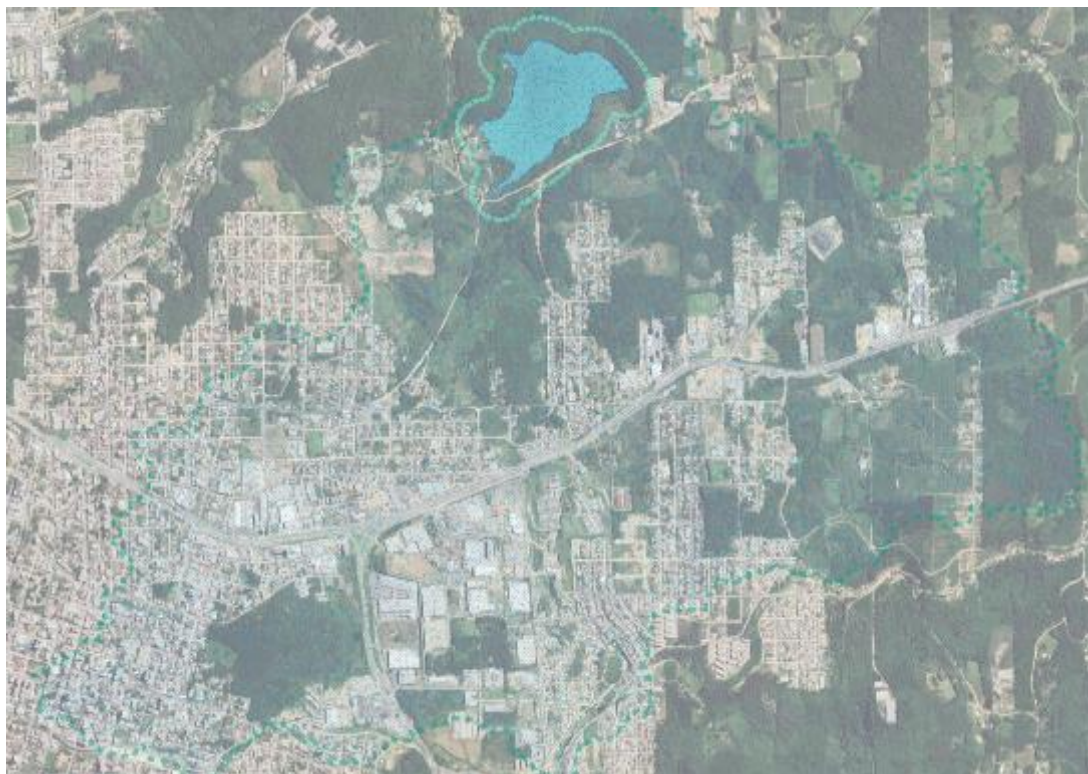
Figura 4 - Área de influência Barragem Julieta.
