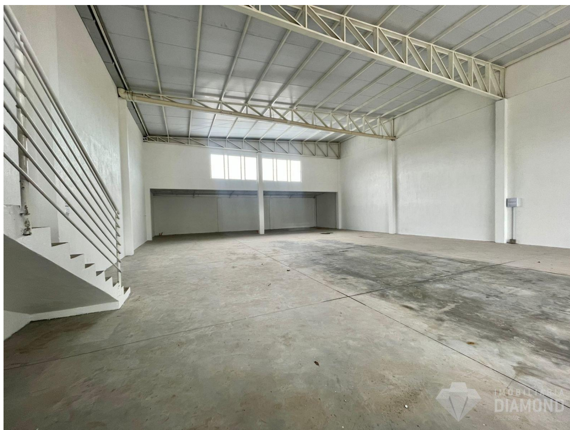
Figura 38 – Vista do mezanino
