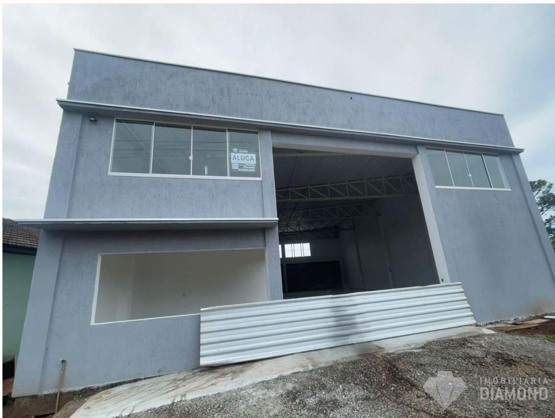
Figura 34- Fachada do local de implantação
