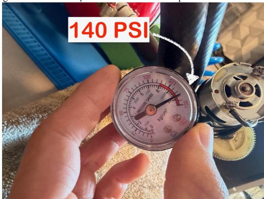
Figura 44 - Pressurização do sistema com o compressor de ar até 140 PSI
