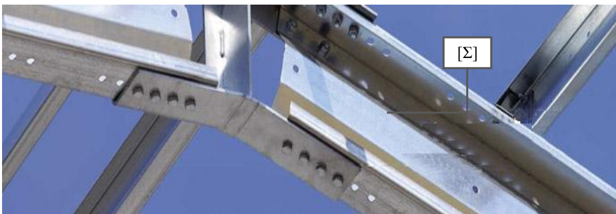
Figura 26 – Aplicação do perfil sigma
