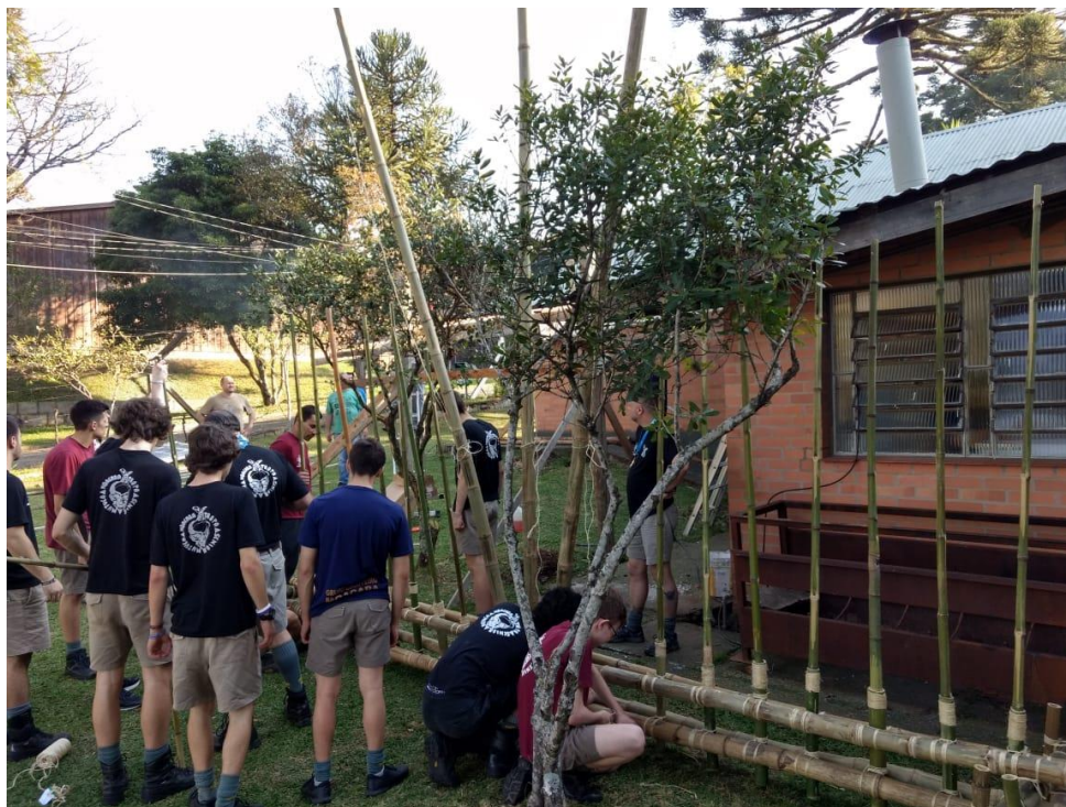
Figura 27 – Construção da pioneiria mastro
