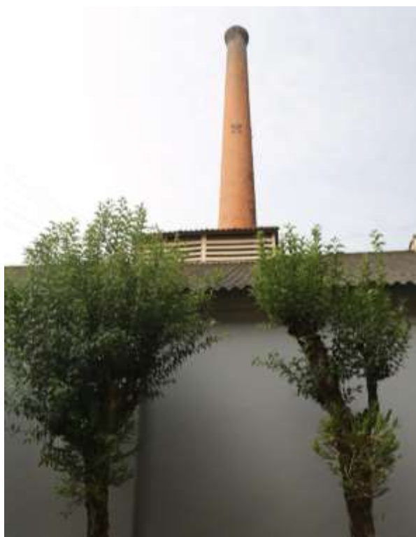
Figura 11 – Visita técnica ao Lanifício São Pedro, atual Cootegal. Destaque para o chaminé - 2023
