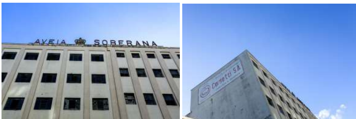
Figura 23 – Vestígios do patrimônio industrial da indústria: produtos Alimentícios Corsetti. Pesquisa de campo - 2023
