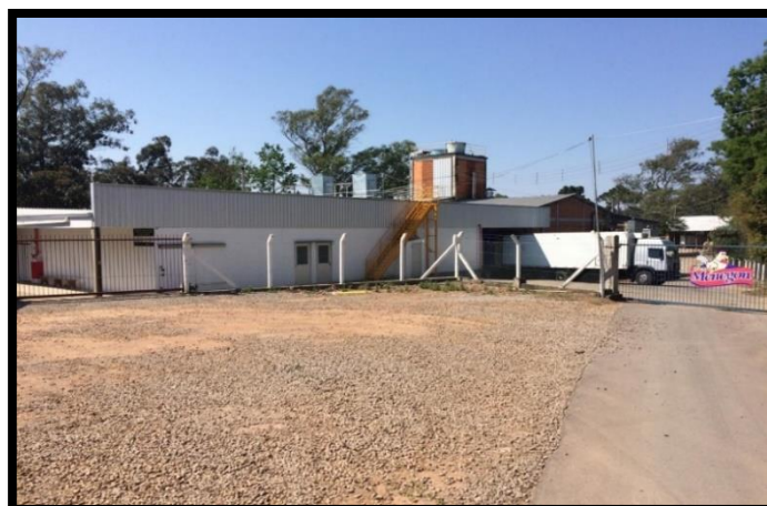
FIGURA 1. Fachada da empresa
