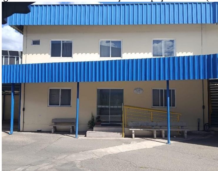
Figura 2 - Área externa do Serviço de Inspeção Federal (SIF)
