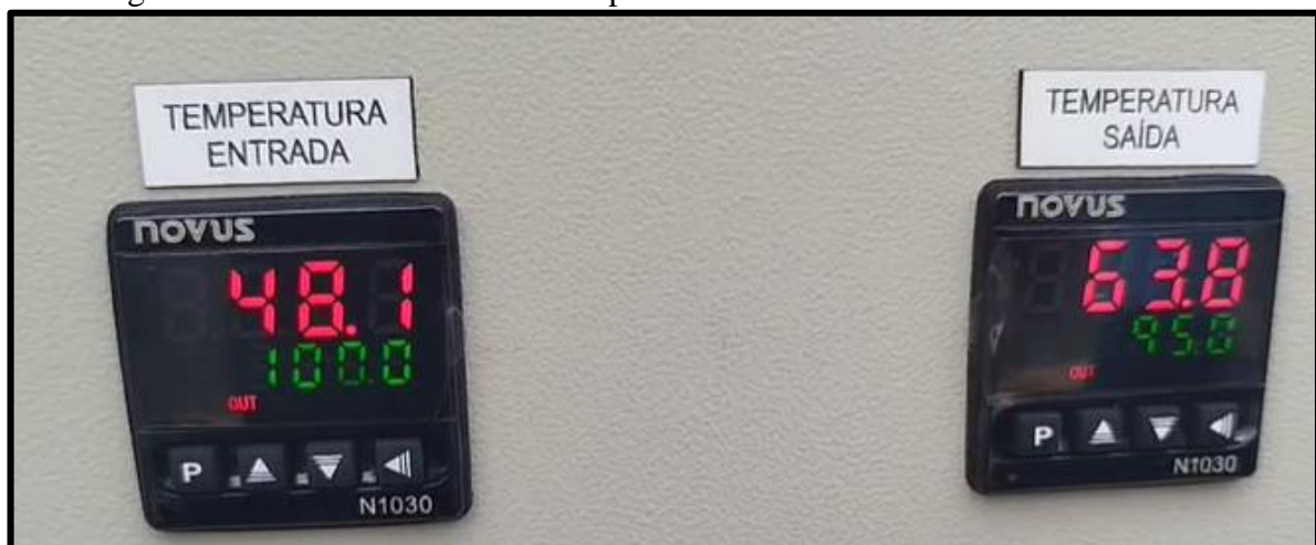
Figura 22 – Monitoramento das temperaturas de entrada e saída do óleo térmico
