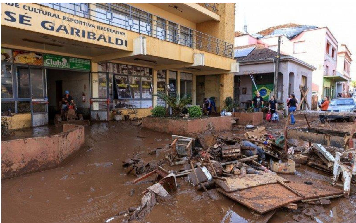
Figura 16 - Entulho deixado após a inundação de setembro de 2023 no comércio local
