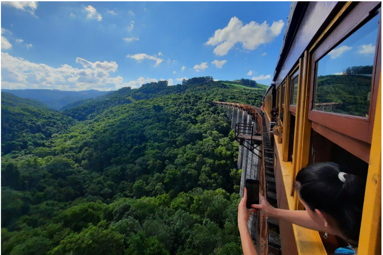
Figura 12 - Foto do Trem passando no viaduto “mula preta”
