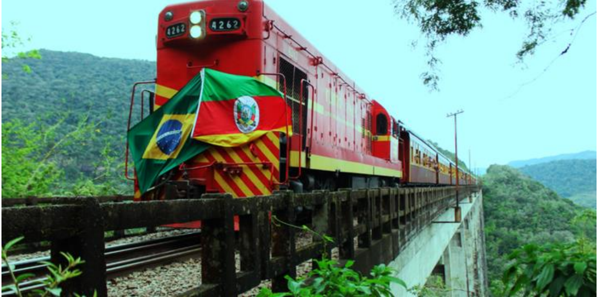
Figura 13 - Locomotiva do trem dos vales passando sobre o Viaduto 13
