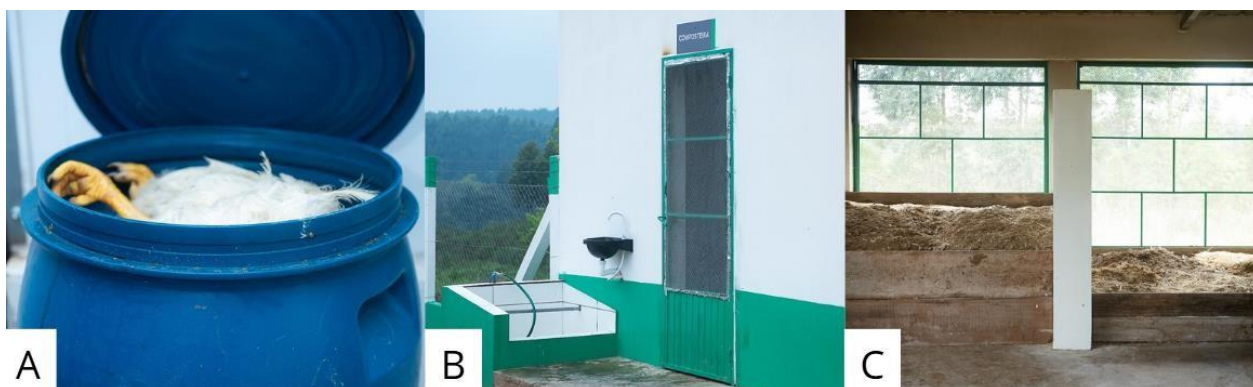
Figura 9: Tambor com aves mortas (A); Entrada da composteira com pedilúvio para lavagem das botas e pia para lavagem das mãos (B) e compostagem na área interna (C).
