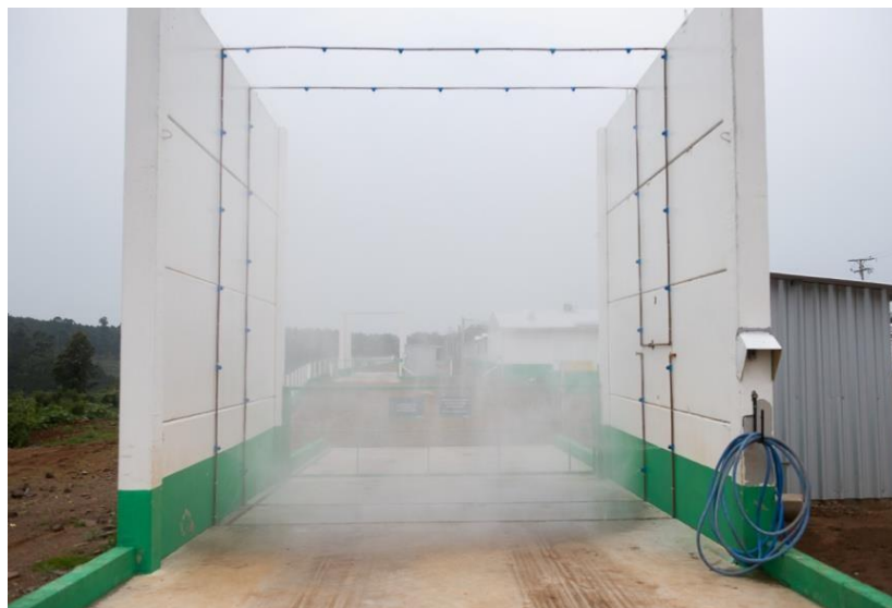
Figura 4: Arco sanitário para entrada de veículos na granja.
