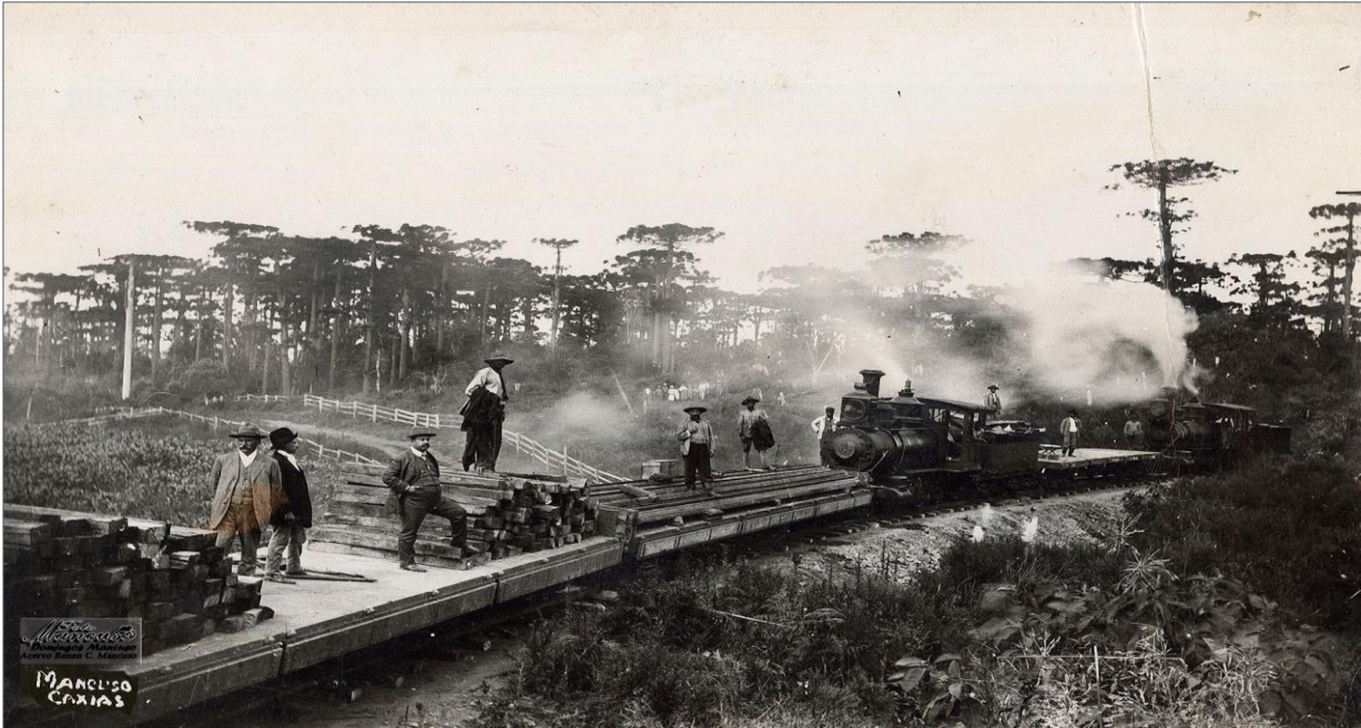
Figura 21 – “O TREM TRANSPORTANDO SUA ESTRADA”. Construção dos últimos quilômetros de trilhos. Entre o final do ano de 1909 e 1910
