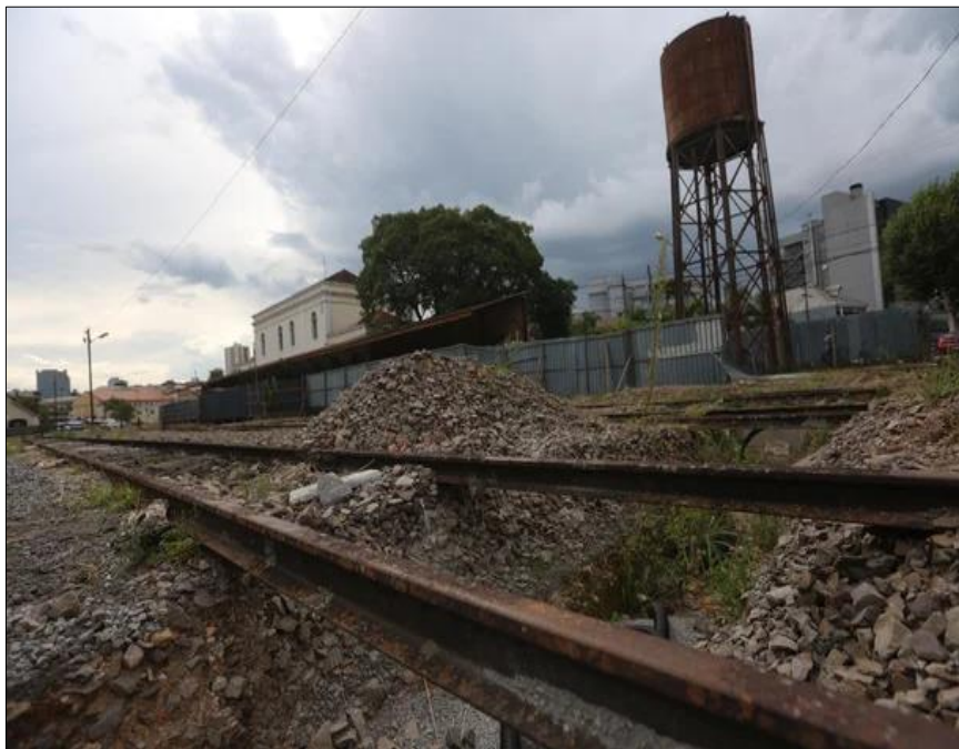
Figura 69 - Obras da revitalização Estação Caxias do Sul. Ano 2025(e)
