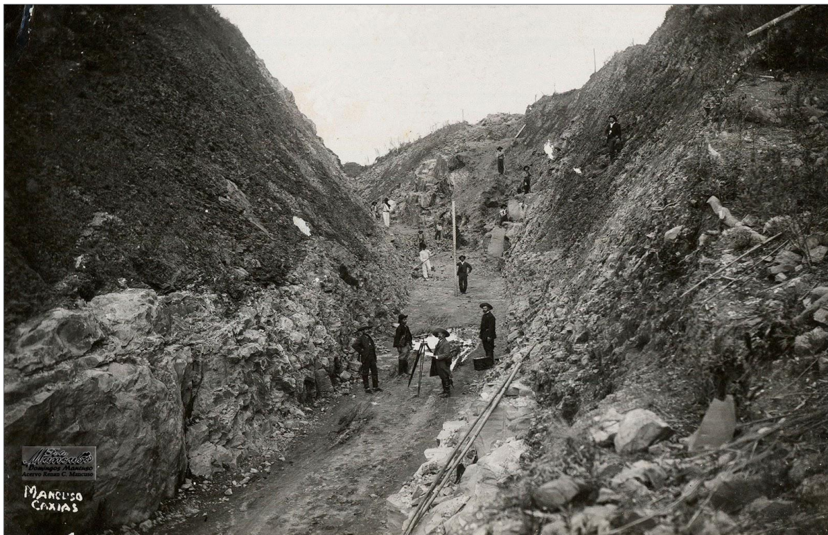
Figura 18 - Obras de terraplanagem da extensão da via. Ano 1909
