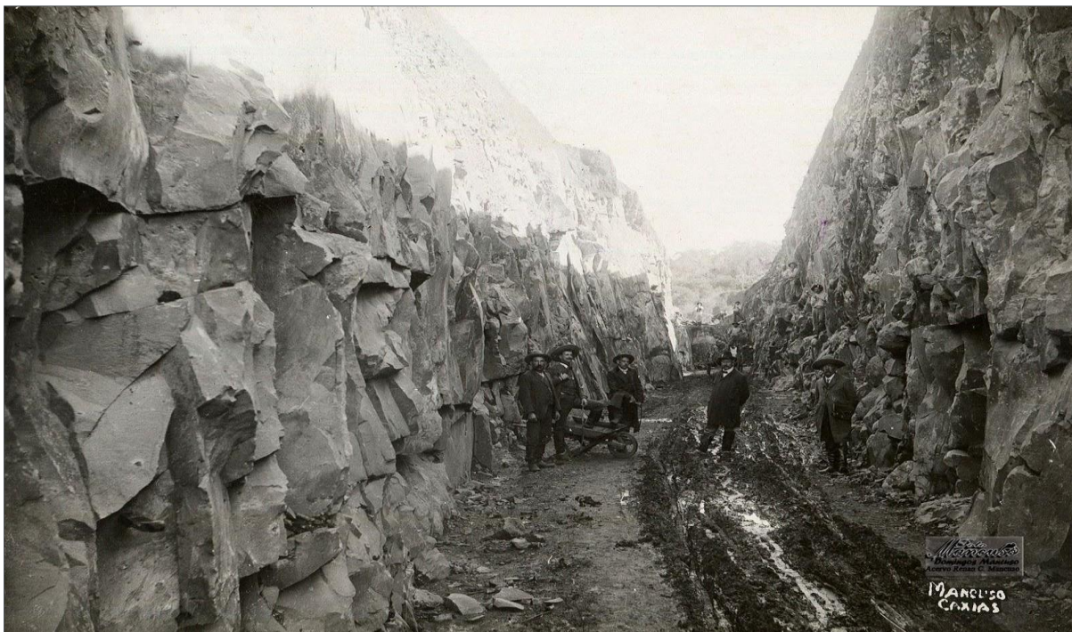
Figura 17 - Seção de desmonte de maciço rochoso. Ano 1909
