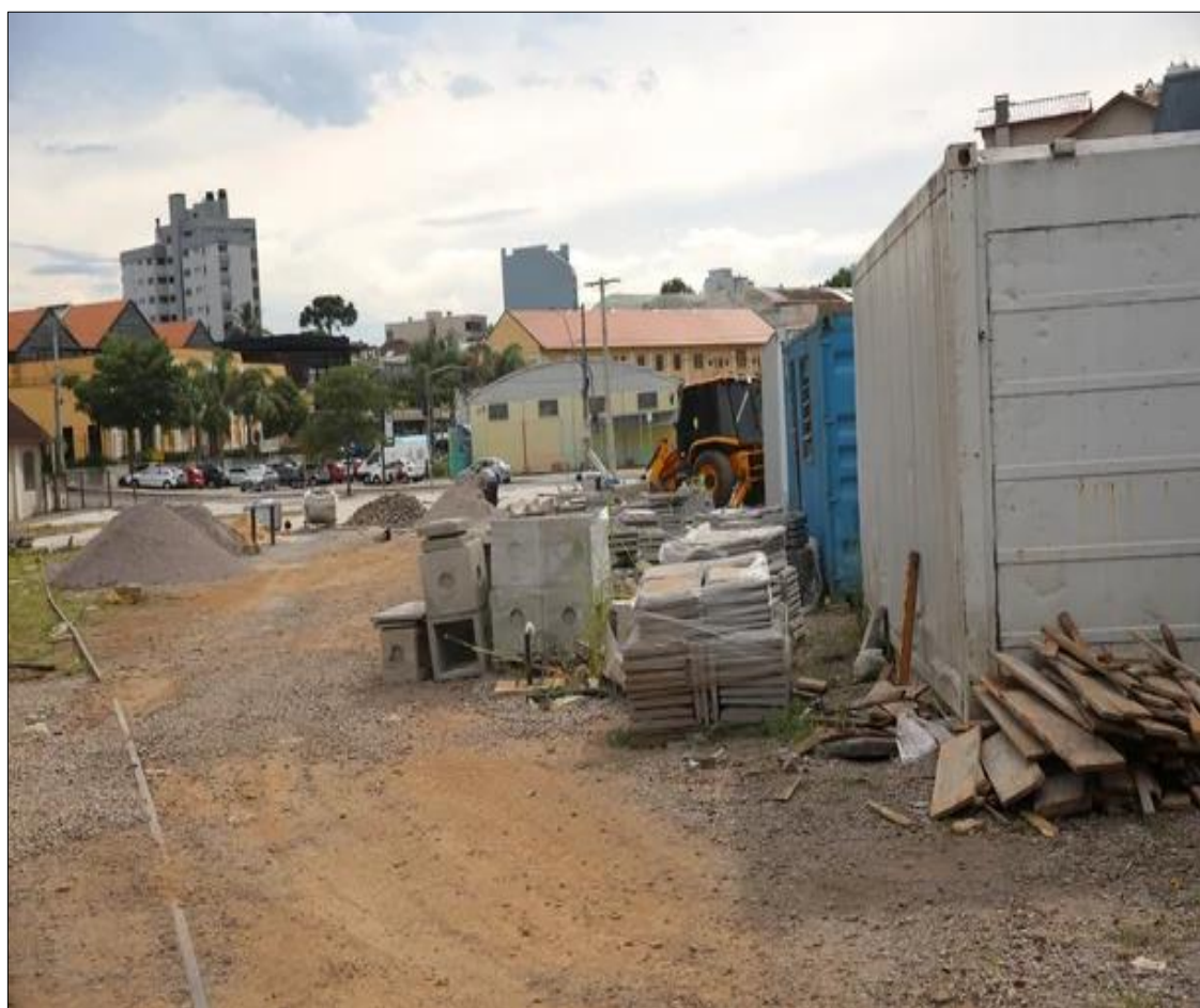
Figura 66 - Obras da revitalização Estação Caxias do Sul. Ano 2025(b)
