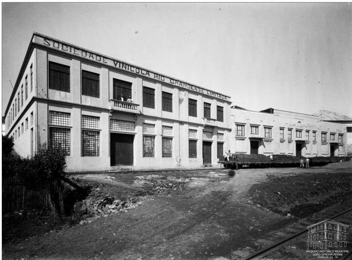
Figura 50 - O prédio mais antigo da Vinícola Riograndense na área da linha férrea, demolido para o prolongamento da Rua Feijó Jr.
