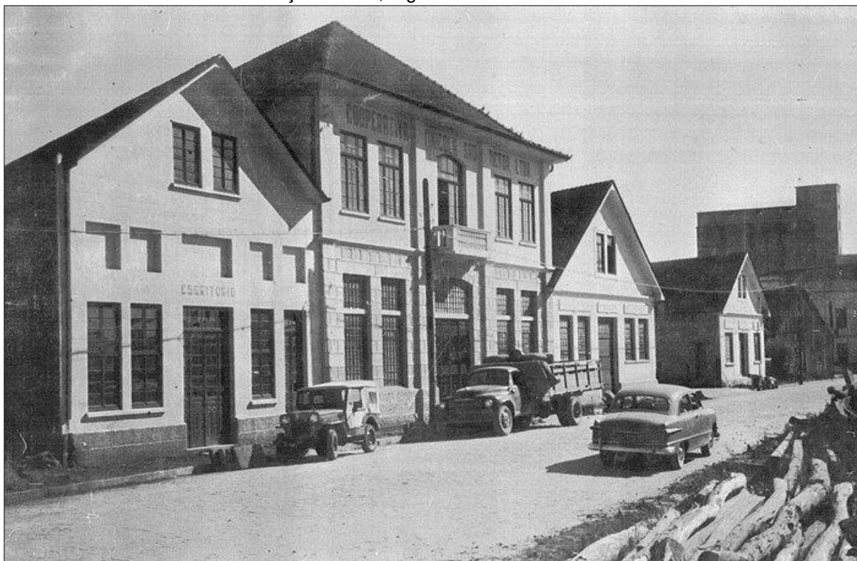
Figura 53 - Registro da fachada da Cooperativa Vinícola São Victor, na Rua Augusto Pestana, em frente à Estação Férrea, registro em meados dos anos 1940
