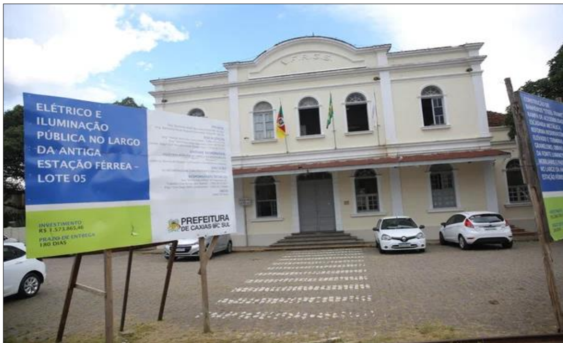
Figura 65 - Obras da revitalização Estação Caxias do Sul. Ano 2025(a)
