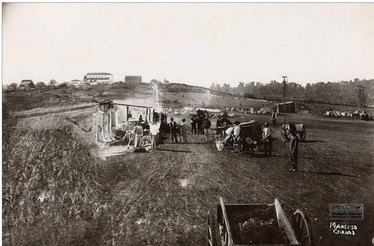
Figura 31 - Obras da construção da estação ferroviária de Caxias do Sul. Ao fundo, o centro da cidade e a Catedral de Santa Thereza. Ano 1909
