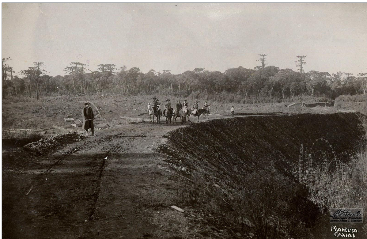
Figura 19 - Técnicos supervisionando a etapa construtiva. Caxias do Sul. Ano 1909
