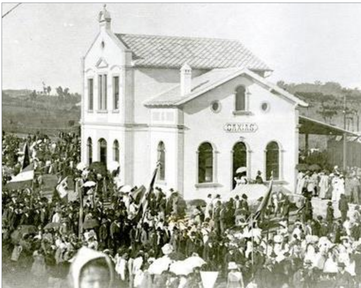
Figura 32 - Estação Ferroviária de Caxias. Ano 1910 (recorte de fotografia original)
