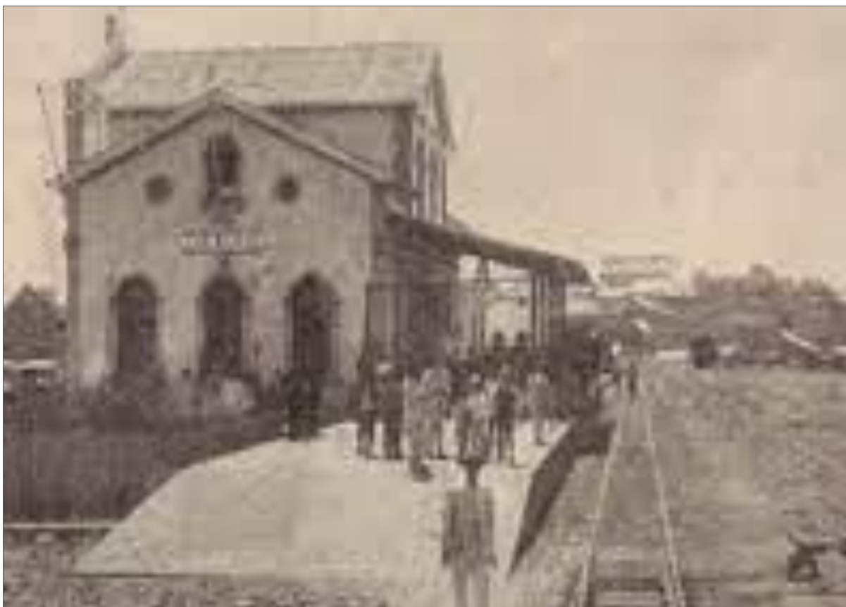
Figura 33 - Vista lateral da Estação de Caxias. Ano 1910 (recorte de fotografia original)
