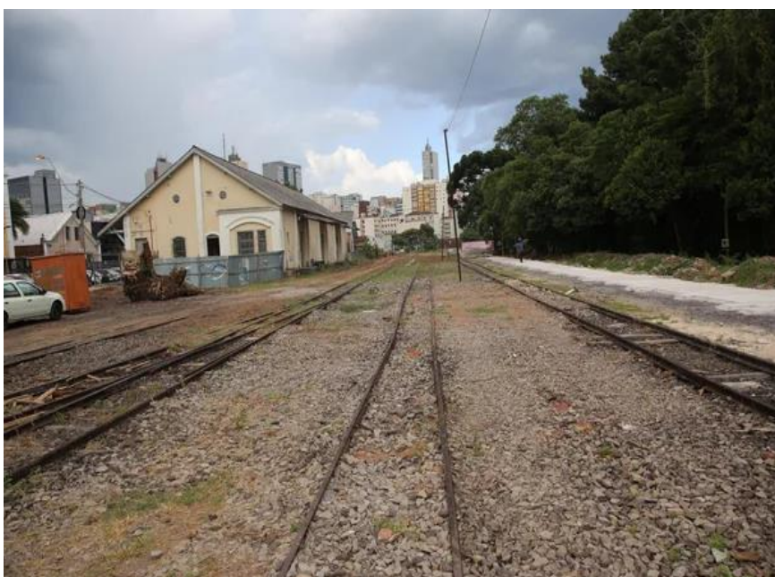
Figura 70 - Obras da revitalização Estação Caxias do Sul. Ano 2025(f)
