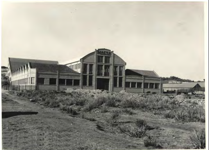
Fachada do Pavilhão da Fundação da MAESA - Fábrica 2, na rua Dom José Barea. Acervo: Arquivo Histórico Municipal João Spadari Adami.
