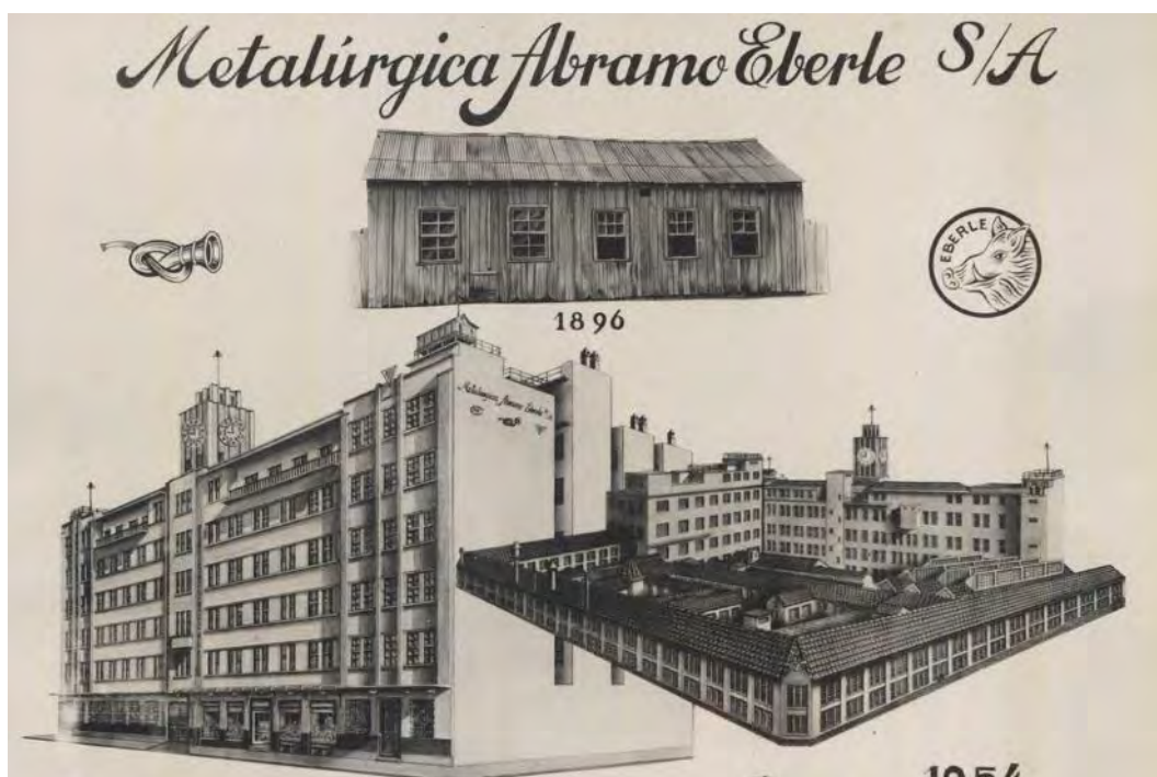
Figura 29 – Prédios da Metalúrgica Abramo Eberle (Fábrica 1), localizada na Rua Sinimbu
