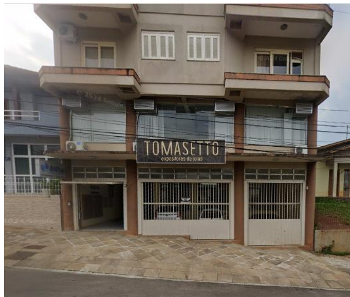
Figura 2 - Fachada atual da empresa
