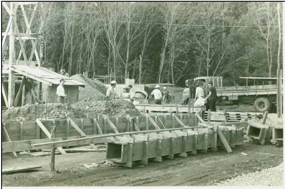
Figura 12 – Obras da construção do prédio da Biblioteca Central
