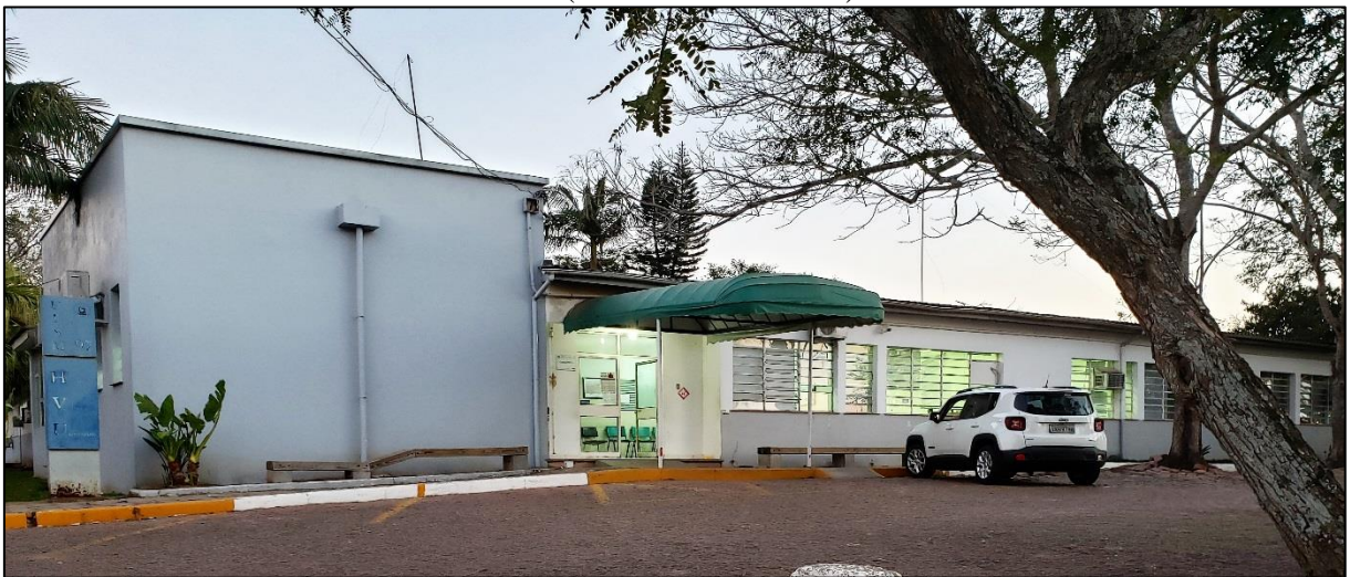
Figura 1 – Hospital Veterinário Universitário da Universidade Federal de Santa Maria/ RS, 2019 (HVU – UFSM/ RS)
