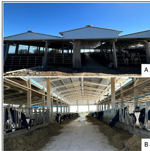
Figura 3 – Estrutura externa do pavilhão 3 (A) e estrutura interna (B)
