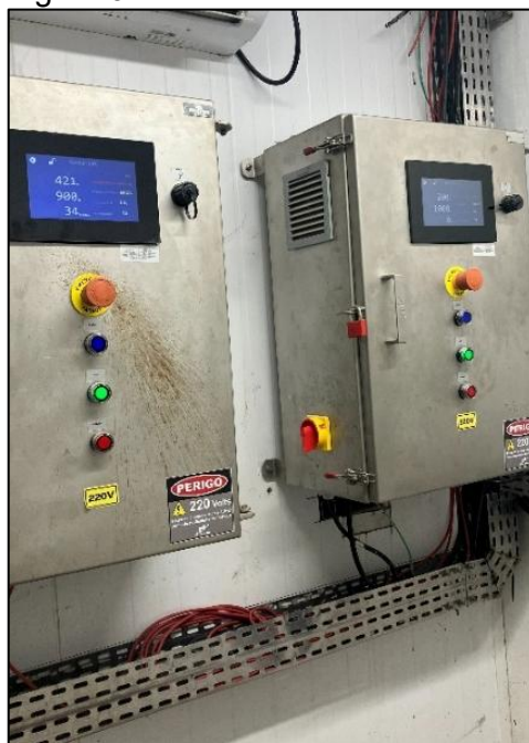
Figura 9 – Painel do insensibilizador.
