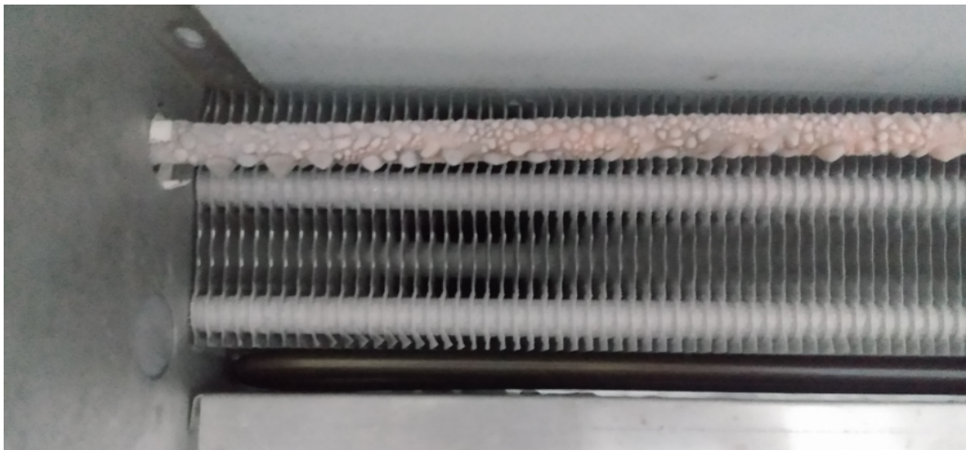
Figura 14 – Formação de gelo normal devido ao processo
