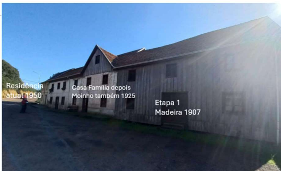
Figura 24 - Moinho atual com as três etapas de construção visíveis
