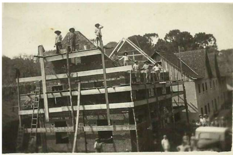
Figura 25 - Construção da atual residência da família
