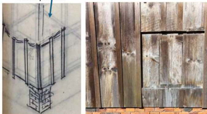
Figura 19- Stülpwände- tábuas sobrepostas
