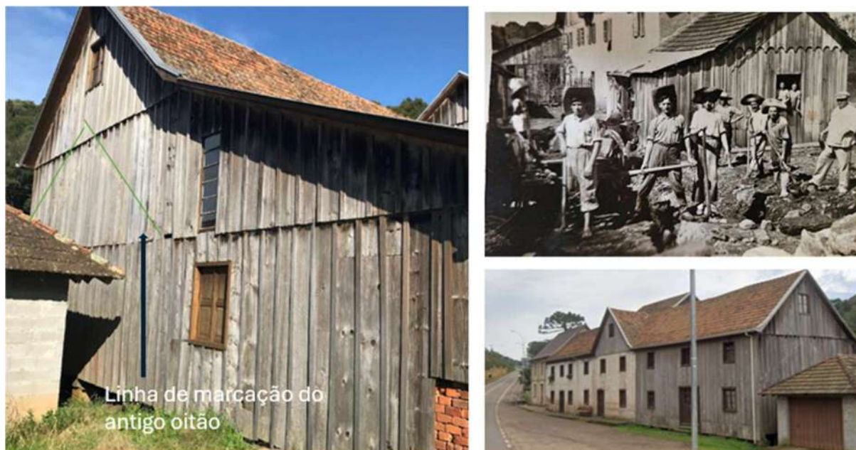
Figura 65 - Edificação em madeira: antes e depois
