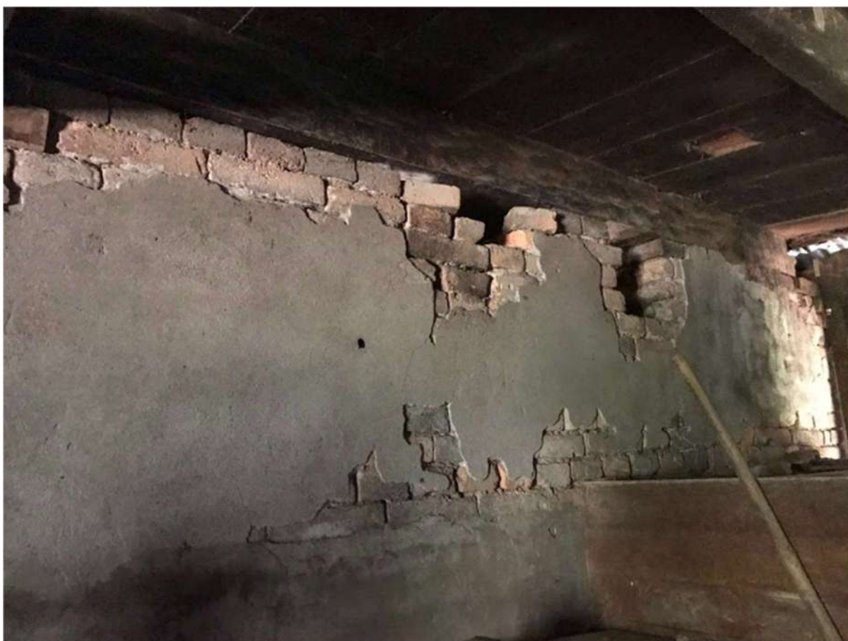
Figura 78 - Parede interna de alvenaria
