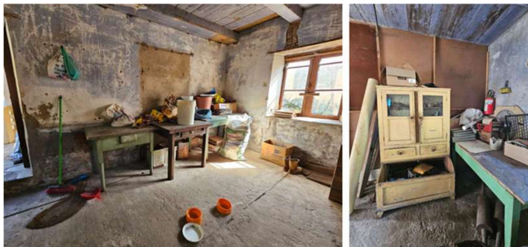
Figura 51 - Antigo depósito de alimentos e acesso ao moinho pela residência
