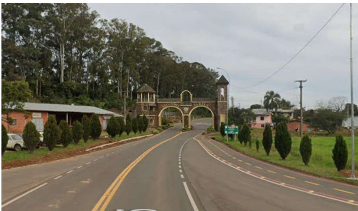
Figura 124 - Pórtico e entorno
