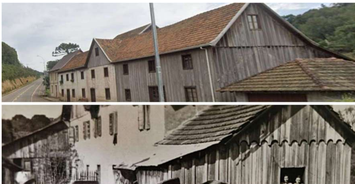
Figura 81 - Janelas: comparativo entre vidro e tampões
