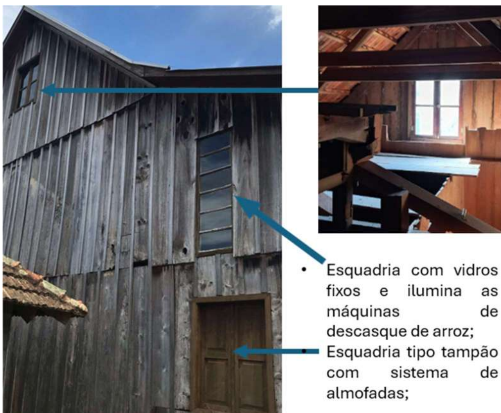
Figura 82 - Esquadrias de madeira na edificação em madeira
