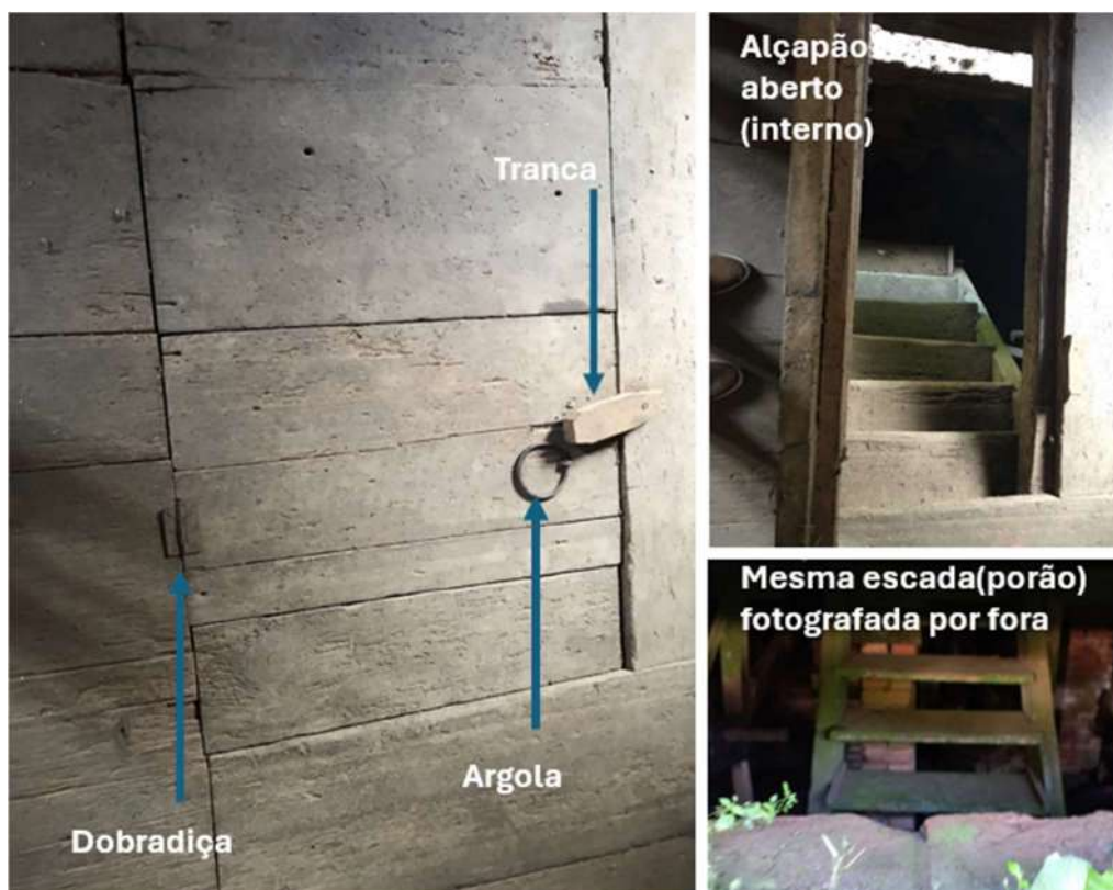
Figura 68 - Alçapão fechado e aberto, e escada de acesso ao porão
