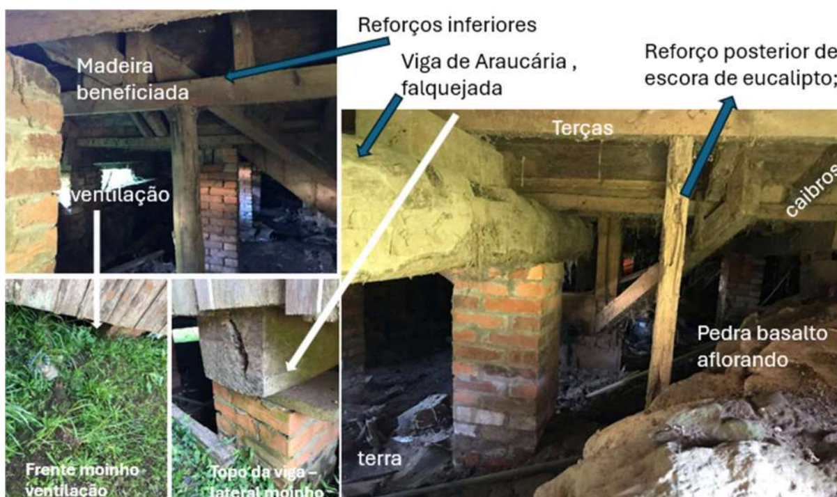
Figura 61 - Porão da parte de madeira
