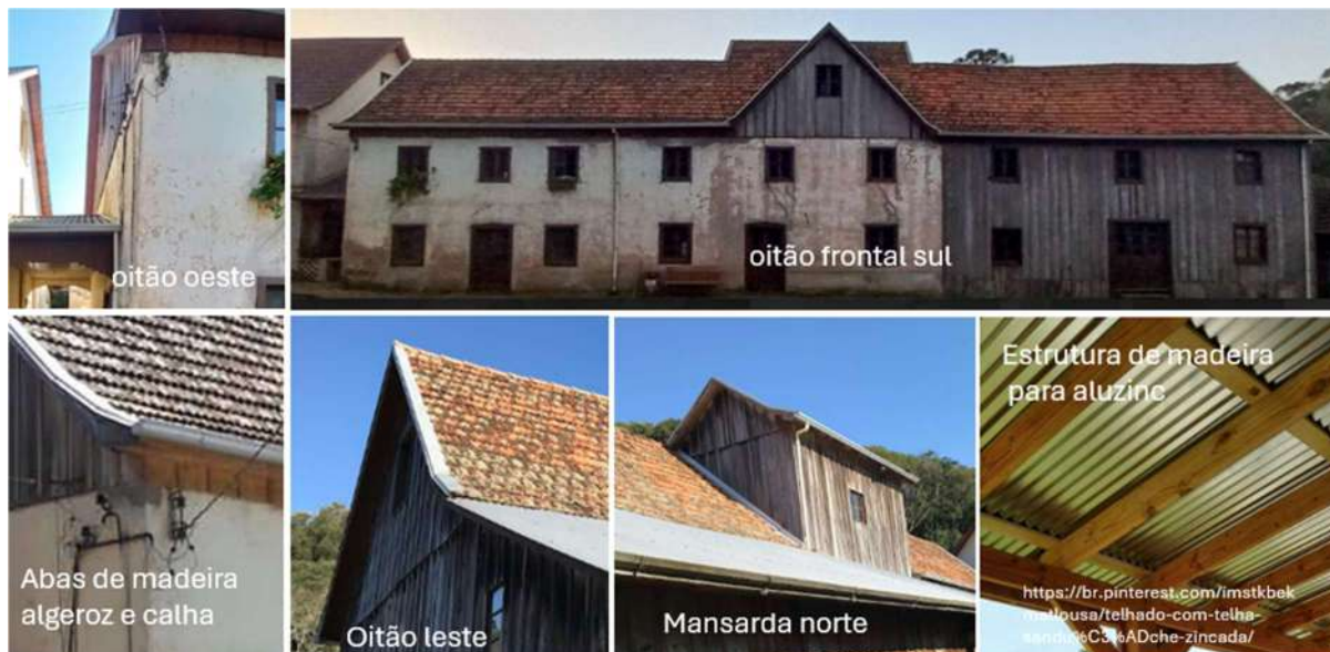
Figura 95 - Oitões, abas e estrutura em aluzinc
