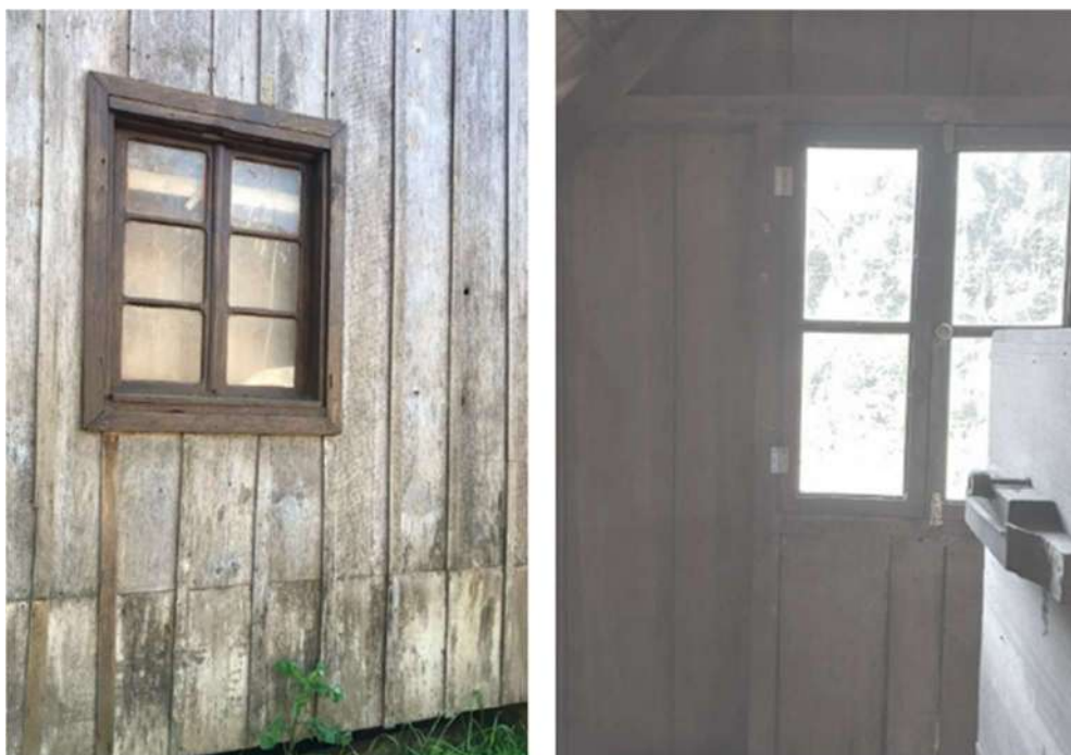
Figura 75 - Fachada frontal e interior em madeira (guias e tábuas)
