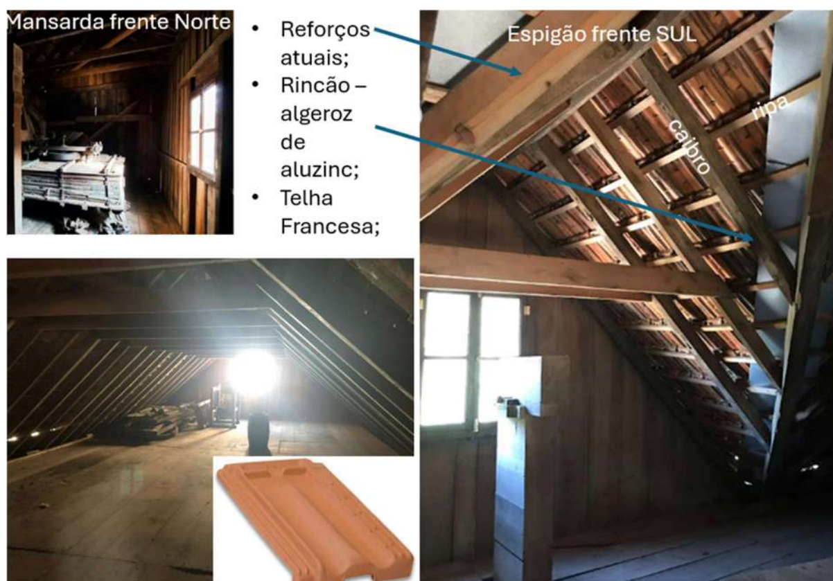
Figura 94 - Telhado: estrutura e parte interna
