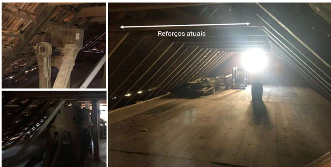
Figura 93 - Telhado interno no sótão
