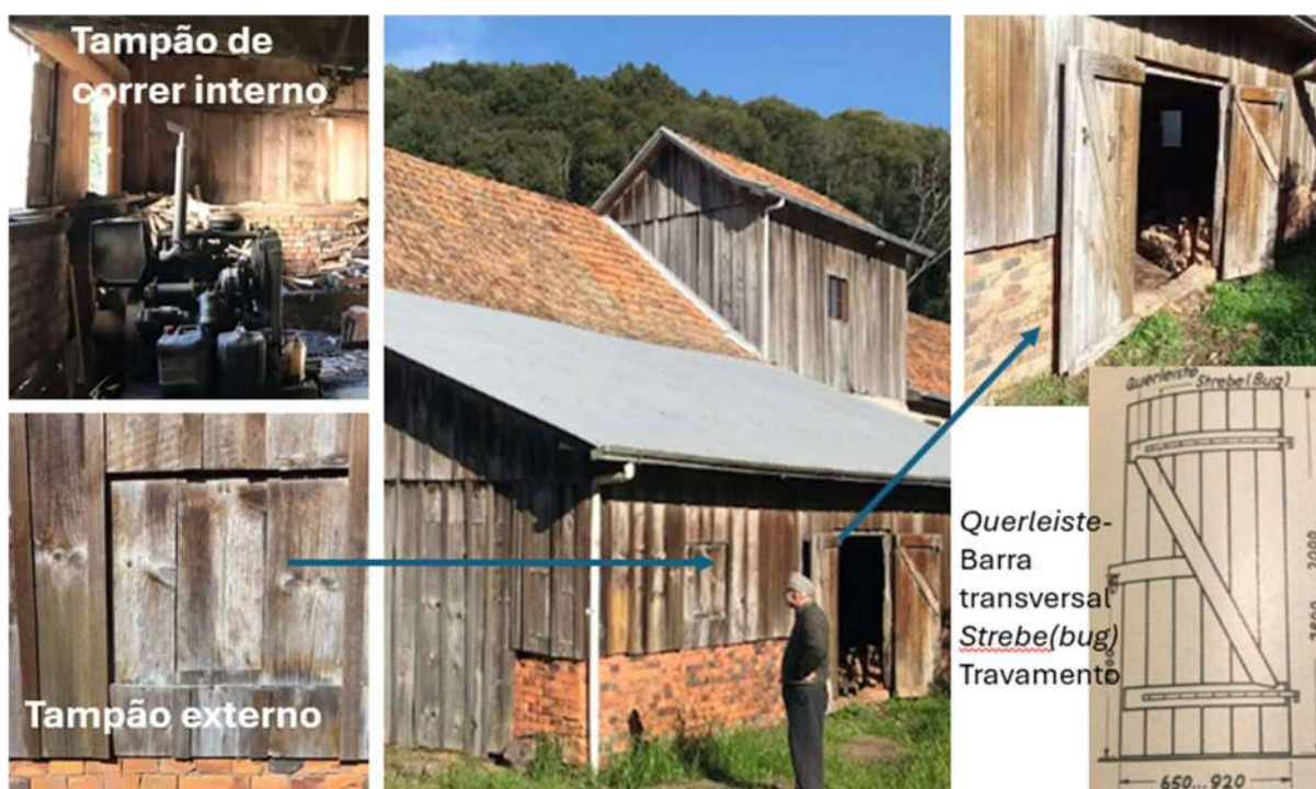
Figura 83 - Esquadrias de madeira e araucária: depósito dos fundos do moinho
