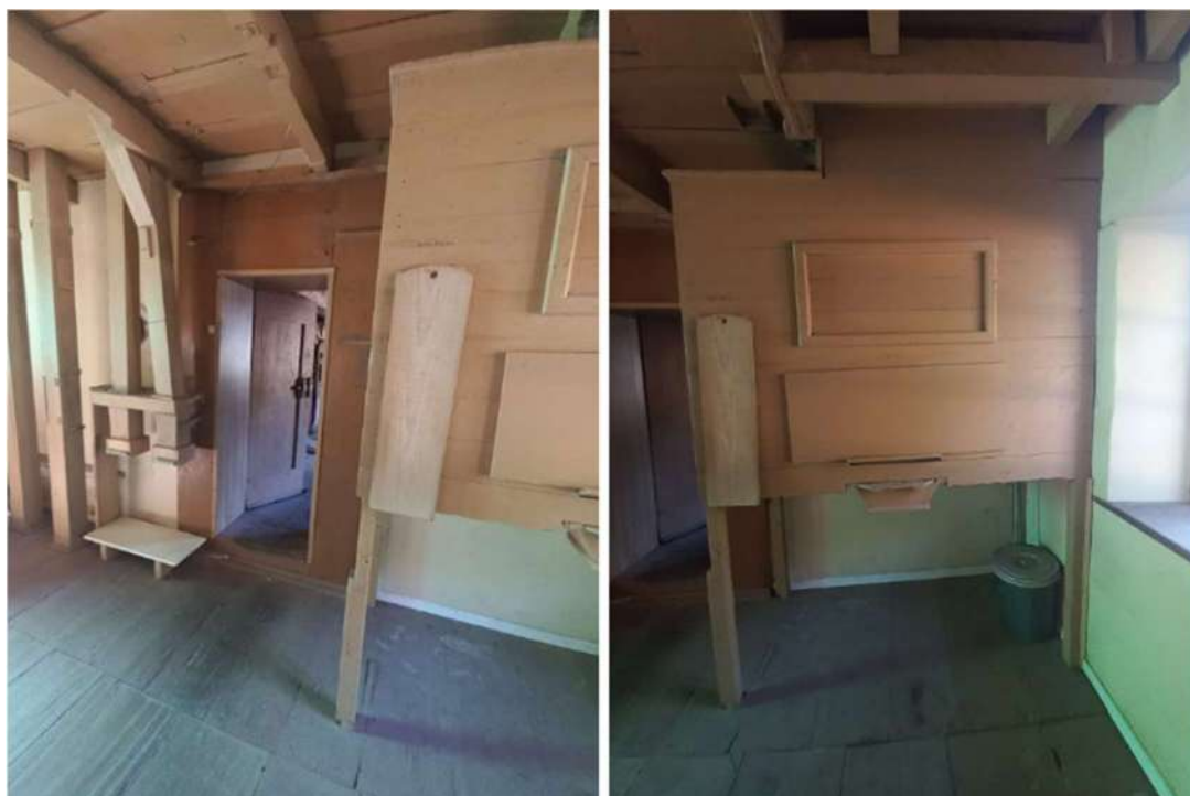
Figura 39 - Dutos de madeira para ensacamento direto e depósito dois - térreo
