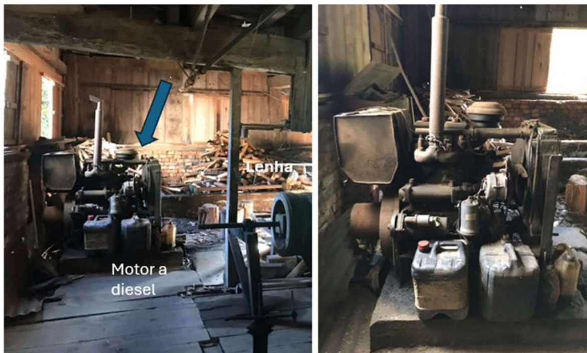
Figura 60 - Motor a diesel
