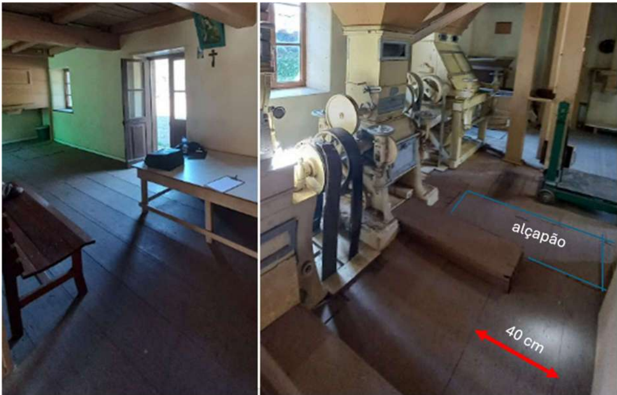
Figura 67 - Assoalho com larguras de 30 a 40 cm, totalmente planas
