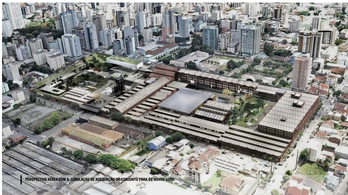
Figura 43 - Plano Geral – perspectiva aérea com simulação de adequação do conjunto para os novos usos
