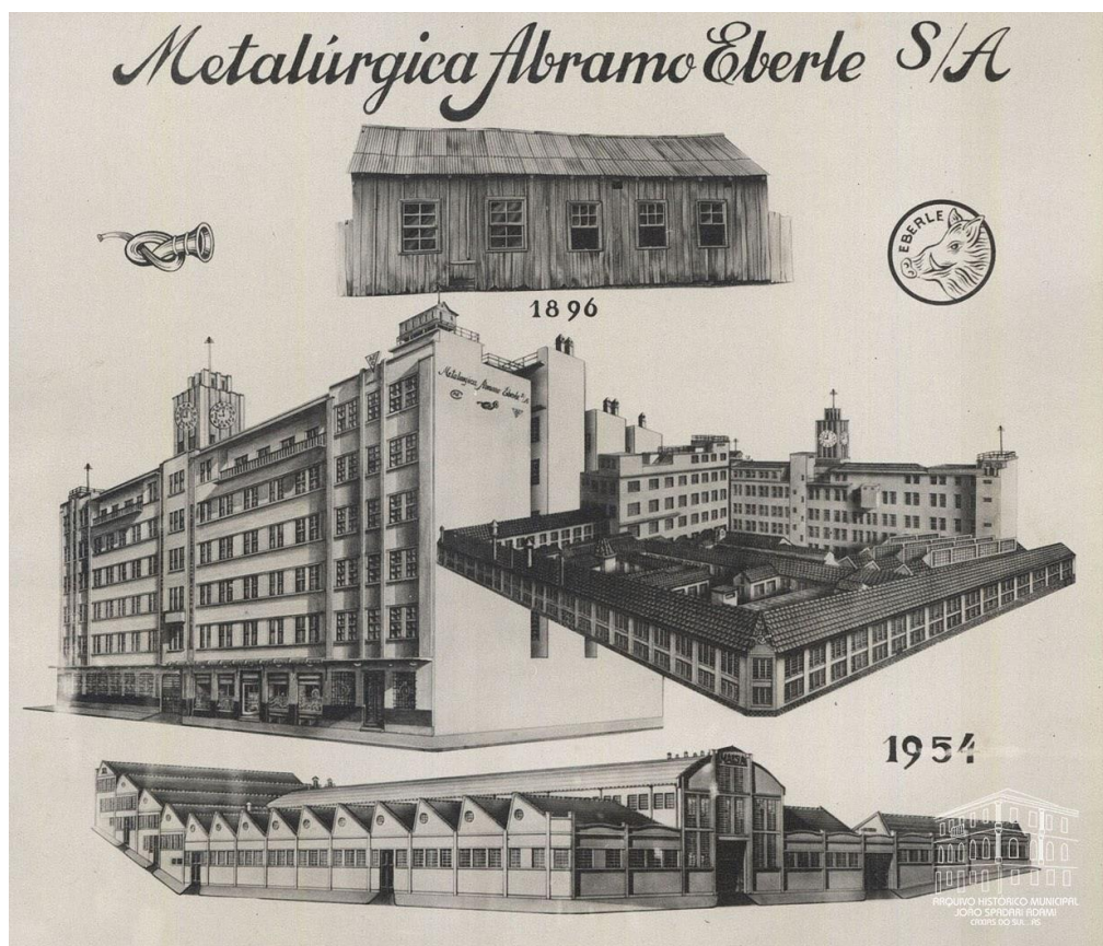
Figura 25 - No topo, a Fábrica 1 no seu início; ao centro, a Fábrica 1 em 1954 e abaixo a Fábrica 2 (MAESA) em 1954
