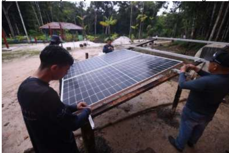
Figura 71 – Instalação de placas solares na comunidade indígena Cipiá
