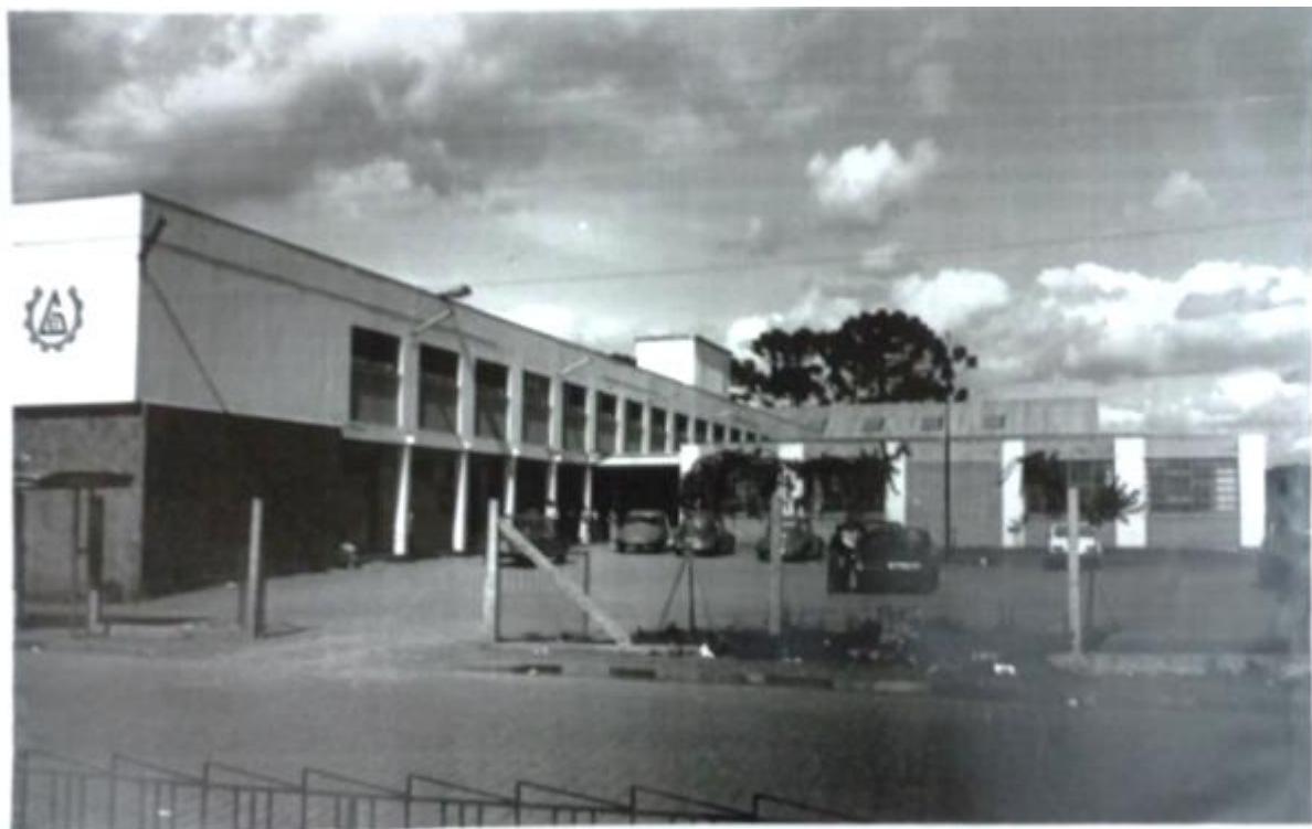
Figura 19 – Fachada da escola em 1971
