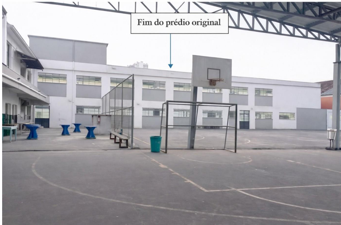
Figura 18 – Fração da fachada interna da escola pelo pátio (2025)
