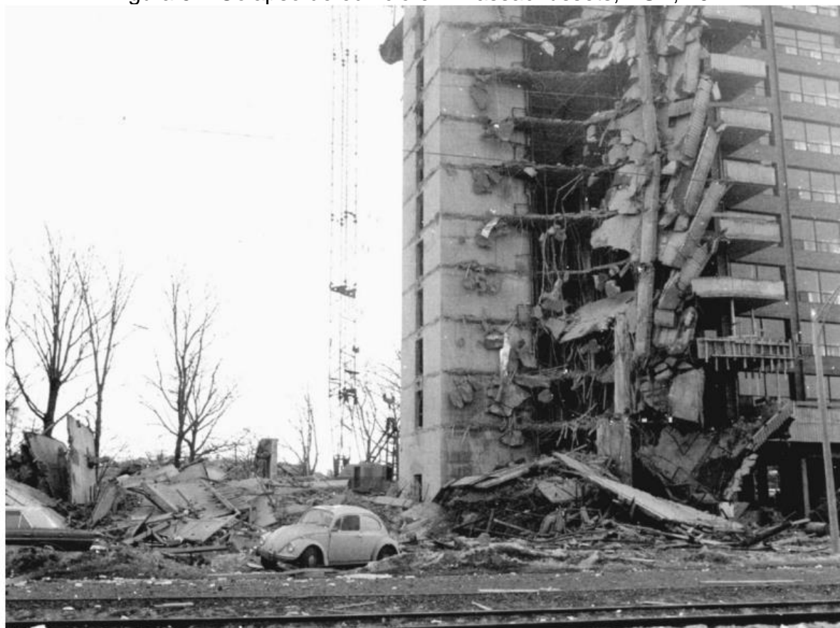
Figura 5 – Colapso de edifício em Massachussets, EUA, 1971
