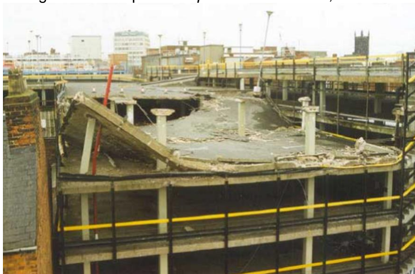
Figura 4 – Colapso do Pipers Row Car Park , em 1997
