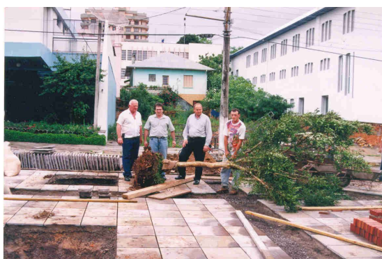
Fotografia 8 – Praça em obras
