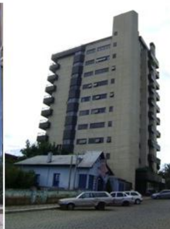
Fotografia 34 - Fundos do prédio visualizado na fotografia 32. Relações de força
