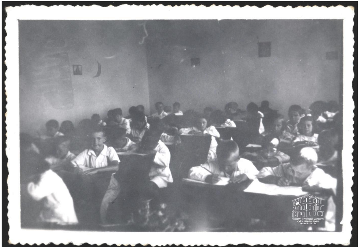
Figura 37 - Sala de aula, Linha Sertorina [19--]
