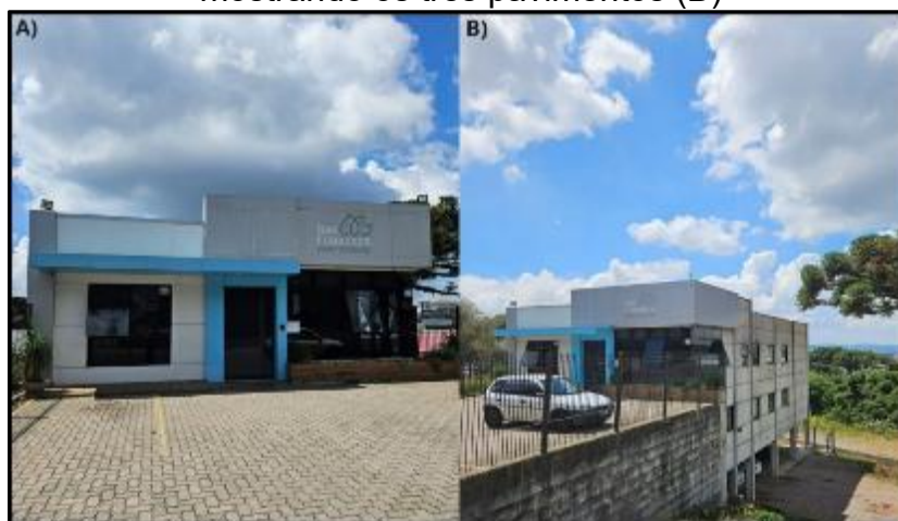
Figura 1 – Vista frontal Centro São Francisco de Assis (A). Vista lateralizada mostrando os três pavimentos (B)
