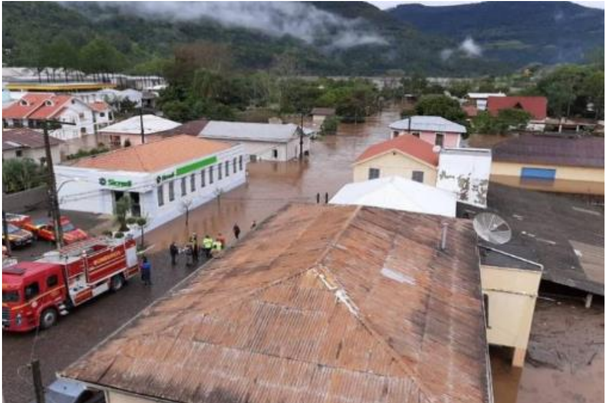
Figura 8 - Enchente maio 2024, vista da Av. Itália.
