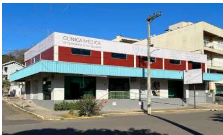
Figura 1 – Fachada da Clínica Médica Veterinária Big Pets
