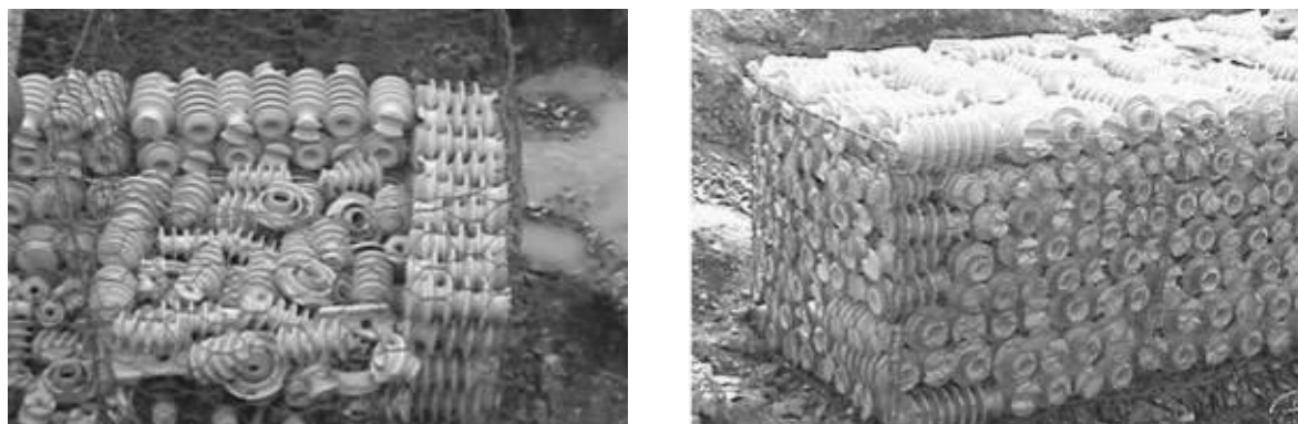
Figura 4. Gabiões para barreiras de contenção fabricados com RIC (FERREIRA et al. , 2010).
