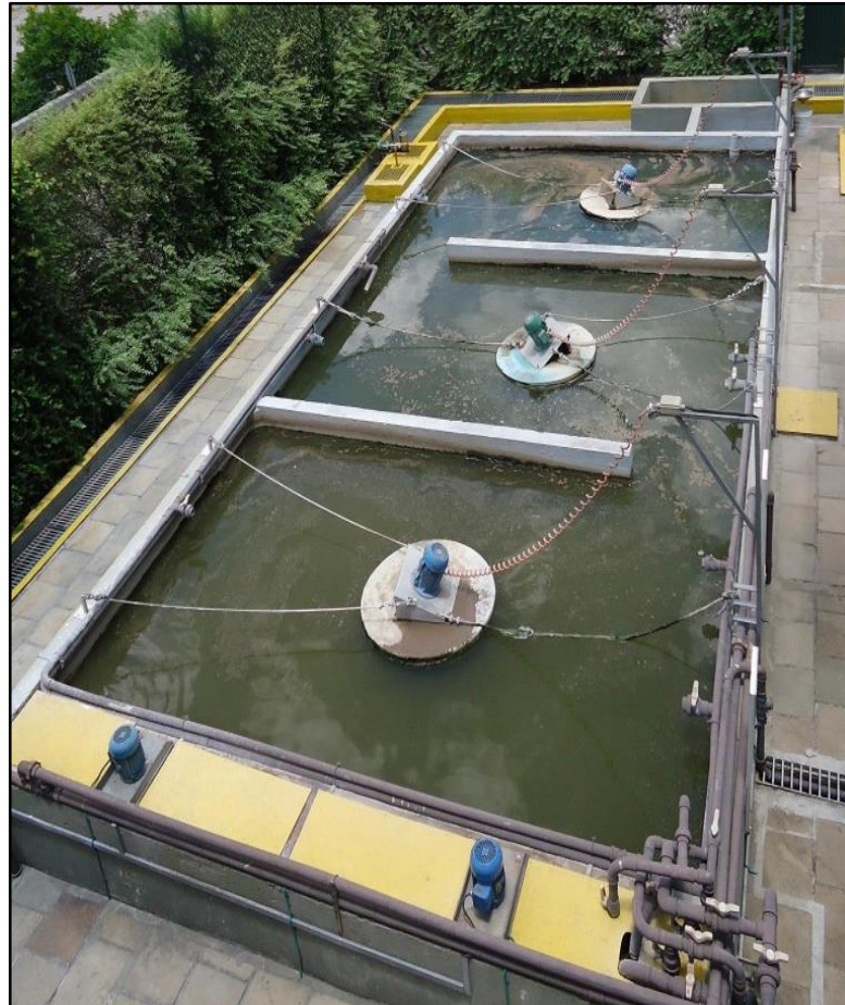
Figura 12: Reator de lodos ativados da indústria de fabricação de embalagens de papelão ondulado
