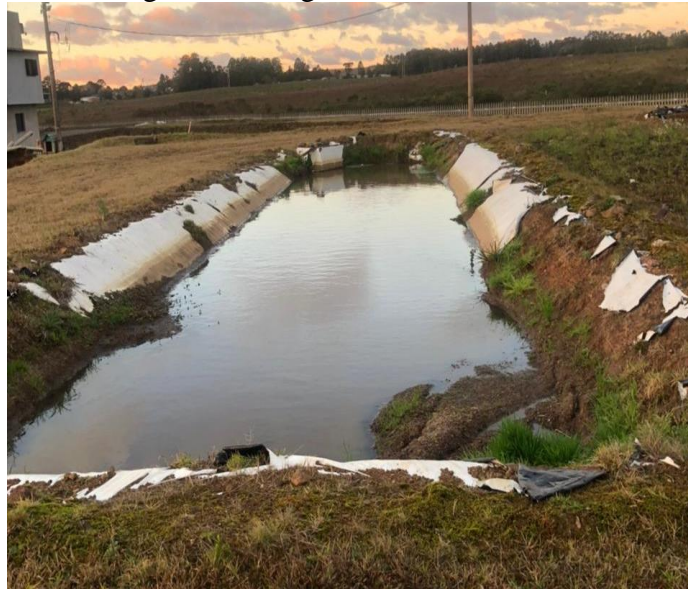
Figura 34 - Lagoa 5 do Sistema ETE
