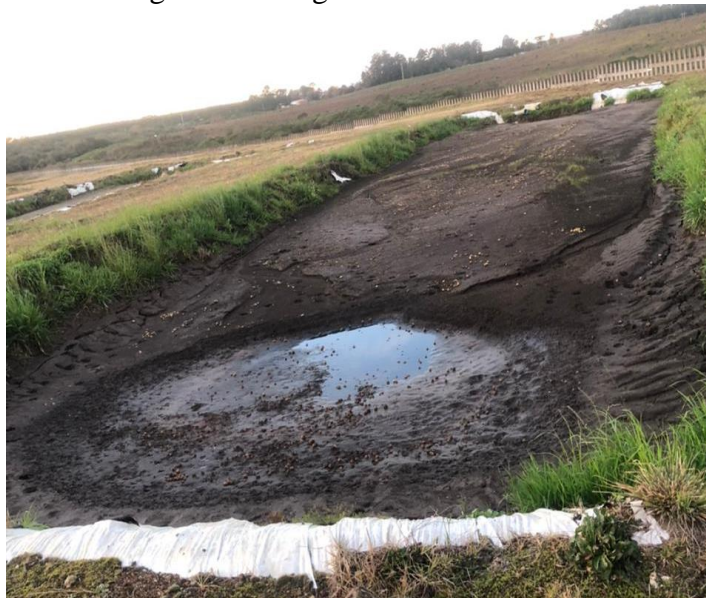
Figura 30 – Lagoa 1 do Sistema ETE
