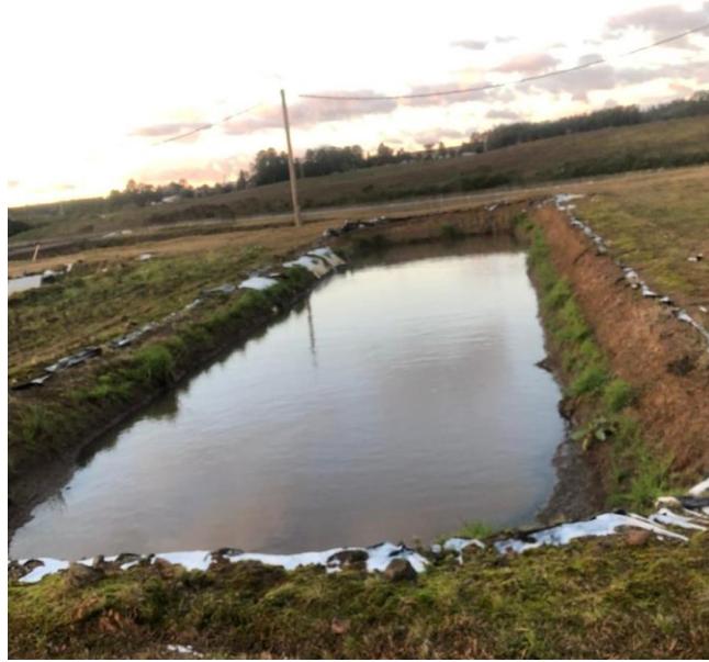
Figura 33 - Lagoa 4 do Sistema ETE
