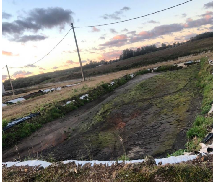
Figura 31 - Lagoa 2 do Sistema ETE
