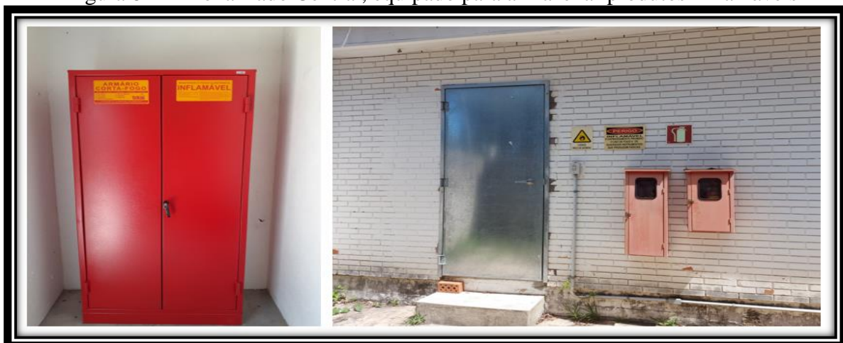
Figura 8 - Almoxarifado Central, equipado para armazenar produtos inflamáveis
