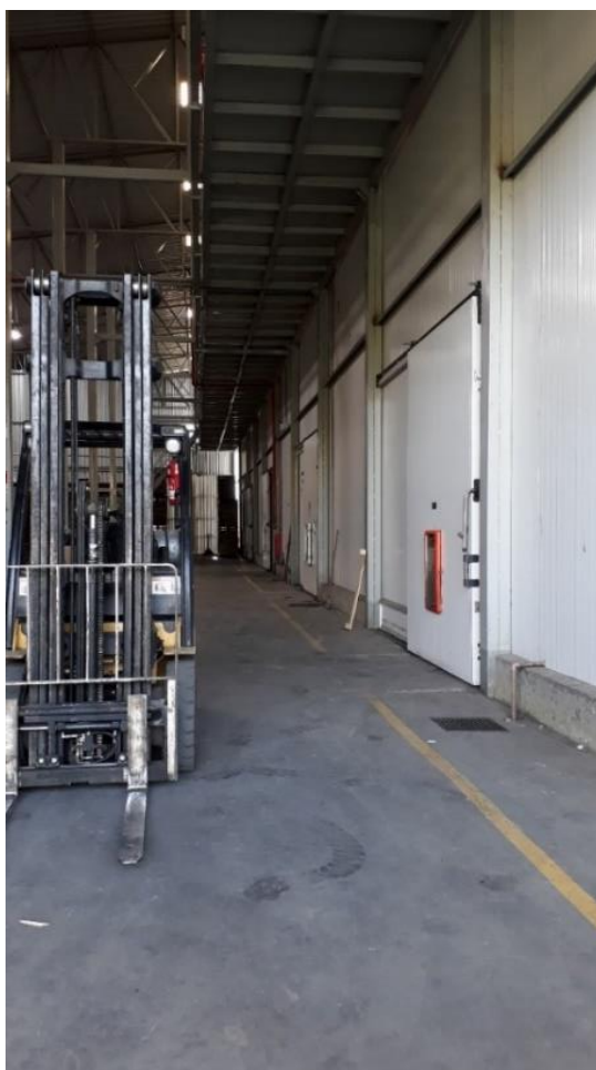
Figura 3 – Acesso às câmaras frias
