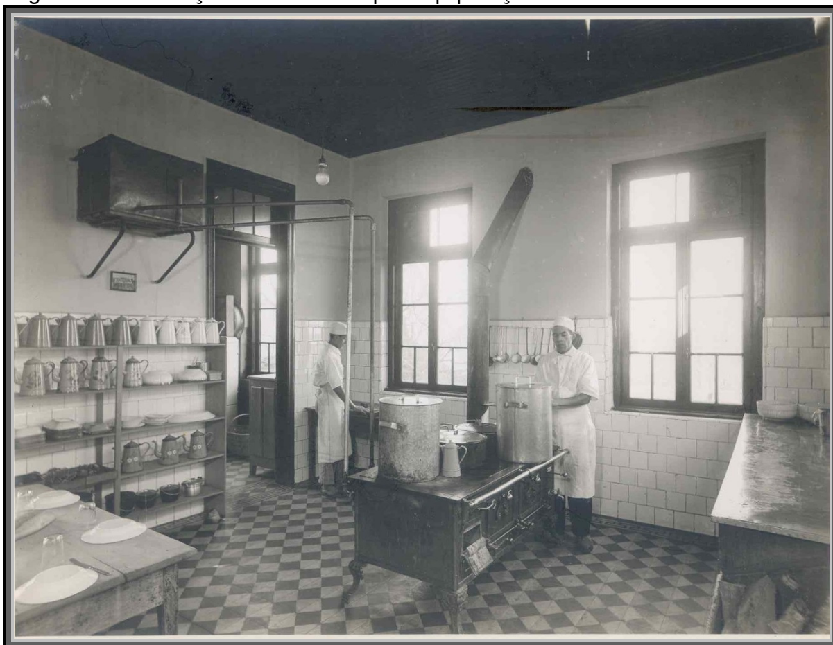
Figura 39 – Instalações da cozinha após equiparação à Ginásio na década de 1930
