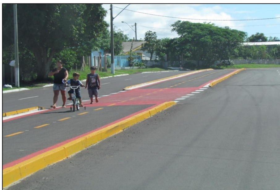
Figura 7 – Ciclovia no município de Osório – RS, inaugurada em outubro de 2014
