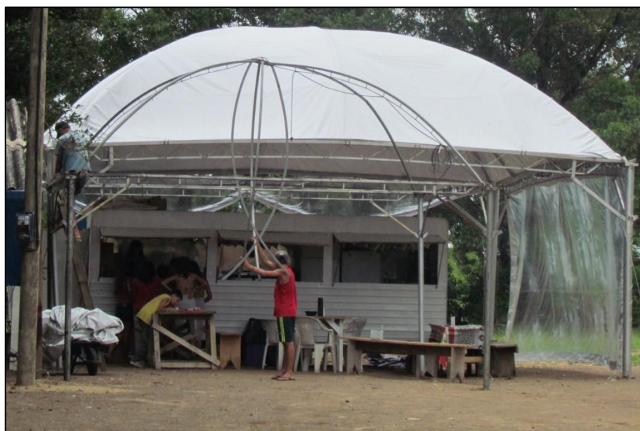
Figura 53 – Montagem da estrutura temporária da lancheria do Camping Municipal Lagoa do Horácio (Osório – RS), disponível somente na alta temporada
