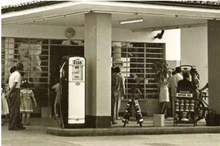
Figura 10 - Fachada do posto de gasolina
