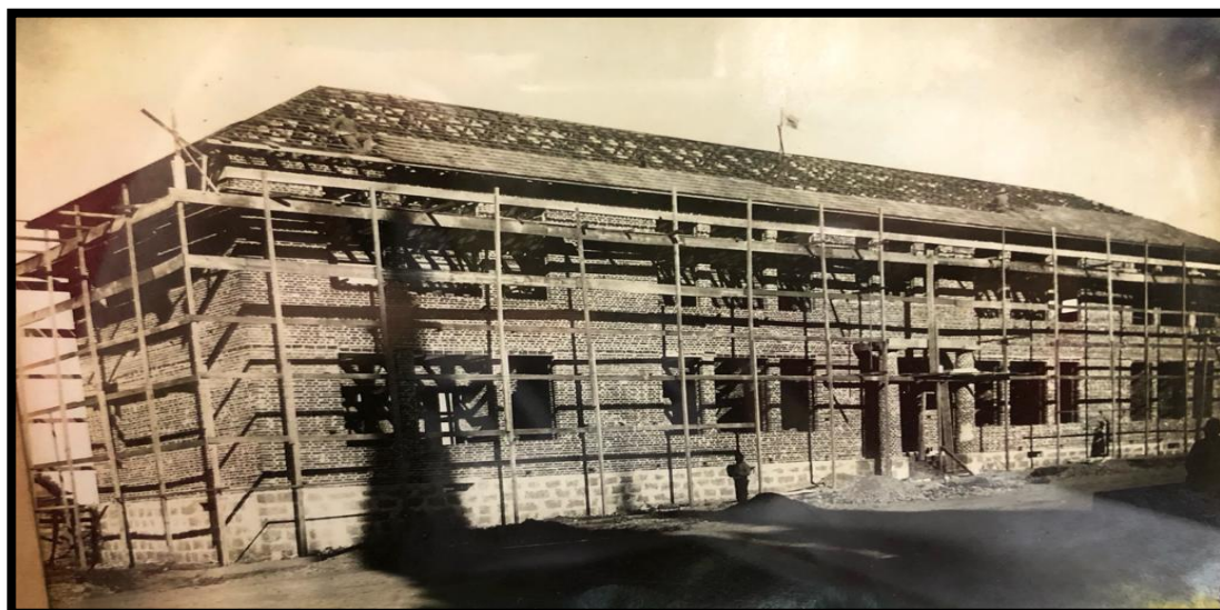
Figura 17 – Construção do prédio do Grupo Escolar Padre Efrem (1935)
