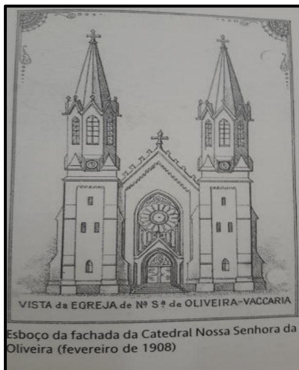
Figura 4 – Esboço da fachada da Catedral, em fevereiro de 1908
