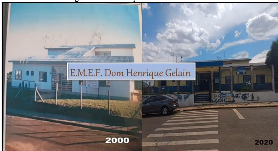
Figura 10 – Mudança na Fachada da Escola
