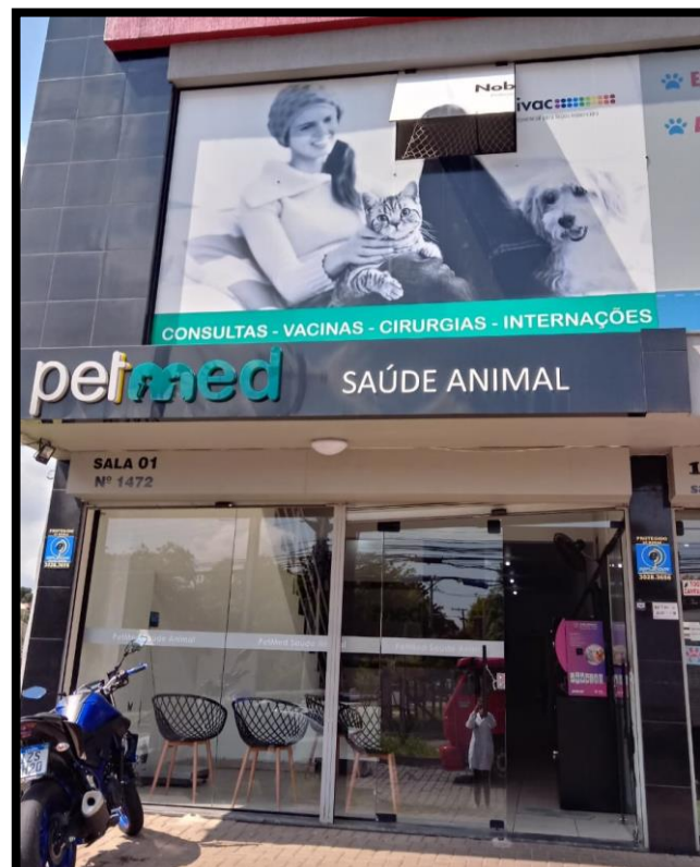
Figura 1 – Fachada da clínica veterinária PetMed
