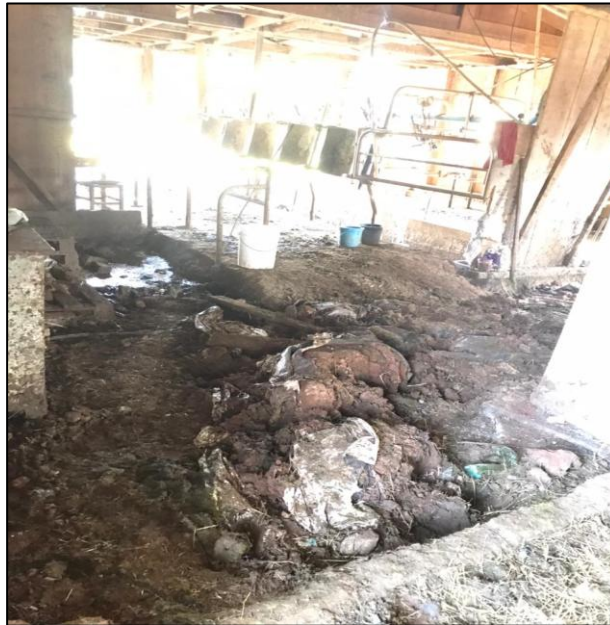
Figura 2- Sala de ordenha com piso irregular.
