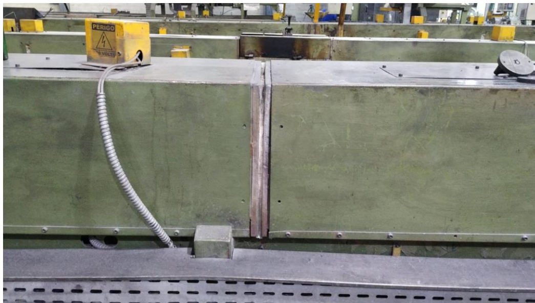
Figura 19 - Junta soldada entre módulos
