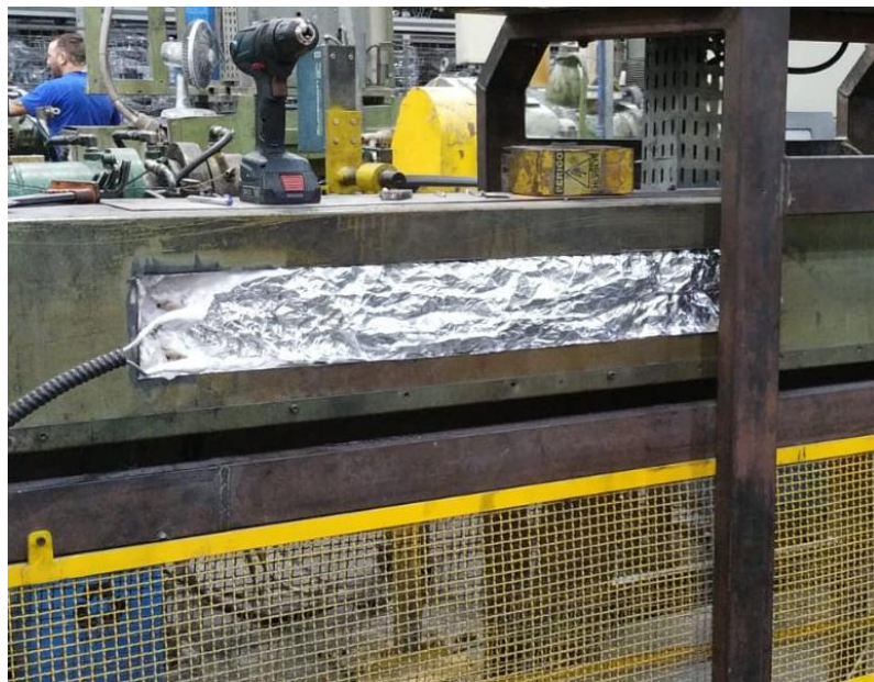
Figura 17 - Isolamento de fibra cerâmica com uma camada de alumínio
