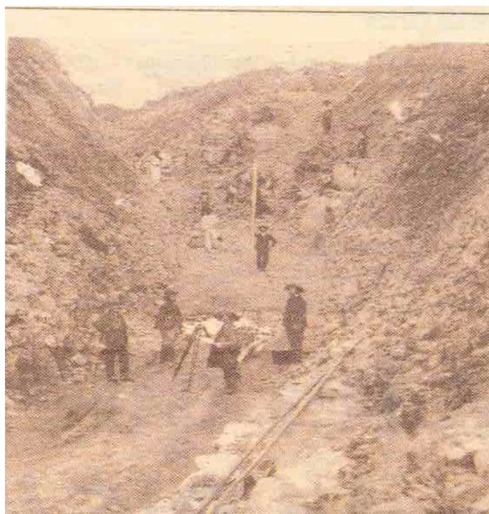
Figura 14 - Obras de construção da via Férrea entre Maratá e Barão
