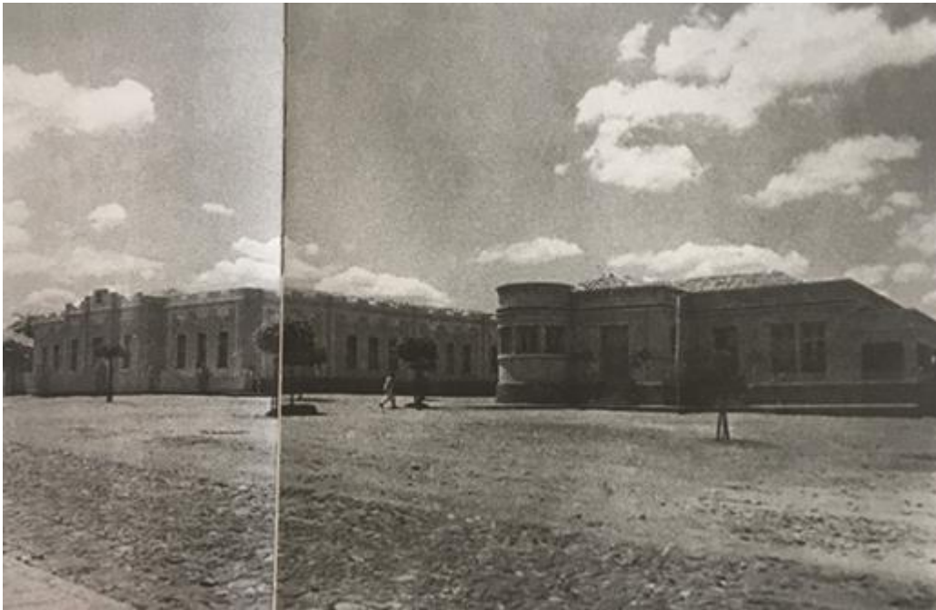
Figura 13 – Vista panorâmica do prédio do Grupo Escolar Padre Cícero, ao lado da Coletoria Estadual de Juazeiro do Norte-CE
