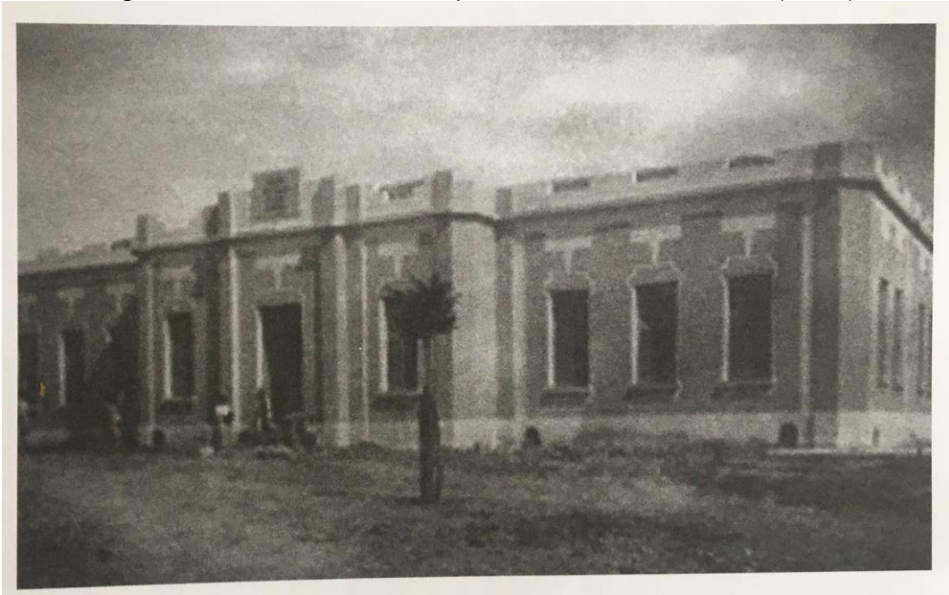
Figura 15 – Fachada do Grupo Escolar Padre Cícero (1935)
