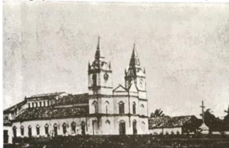
Matriz de Nossa Senhora das Dores, construída pelo Pe. Cícero – 1875-1884. Fonte: Oliveira (2011, não paginado).
