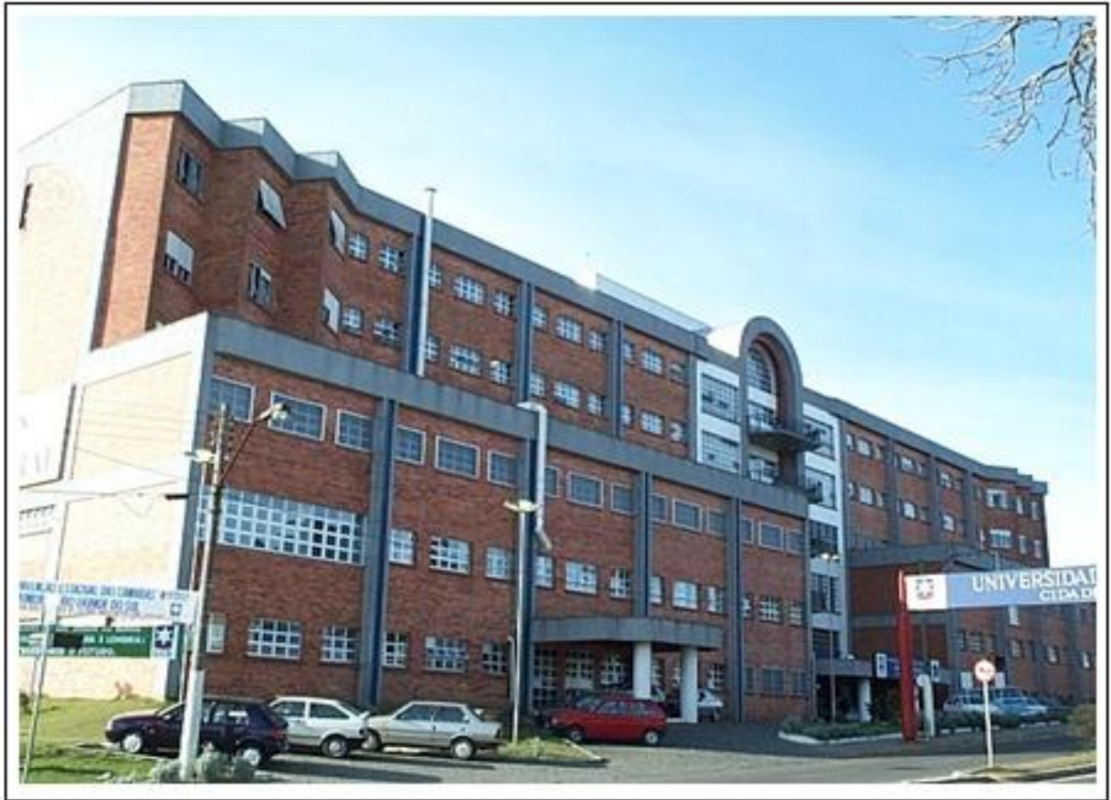
Figura 3 – Fachada do Hospital Geral de Caxias do Sul
