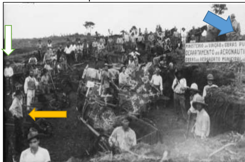
Figura 4 - Início das obras dos primeiros 550 metros do nosso Aeroporto (1935)
