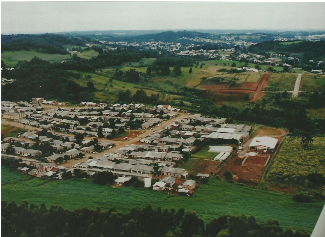
FIGURA 20: Foto aérea do Bairro São João Bosco.
